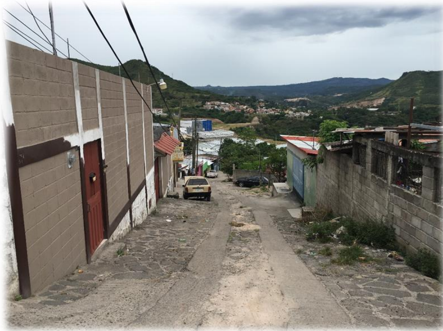
VISTA DE CALLE EXISTENTE A DEMOLER
