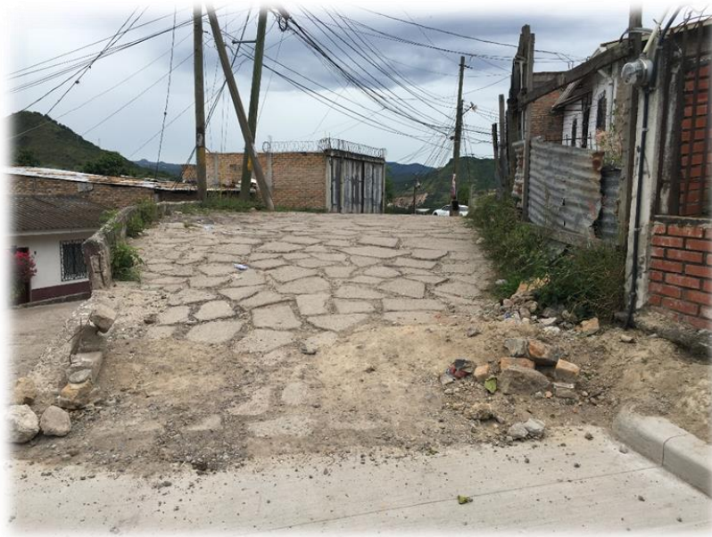
INICIO DE PAVIMENTACIÓN CON CONCRETO HIDRÁULICO
