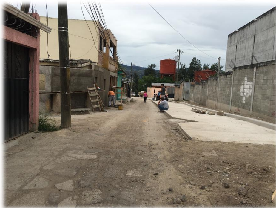
FINAL DE PAVIMENTO CON CONCRETO HIDRÁULICO
