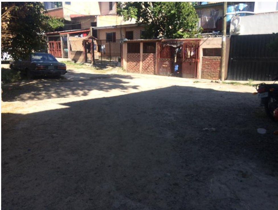
Vista de calle a reparar
