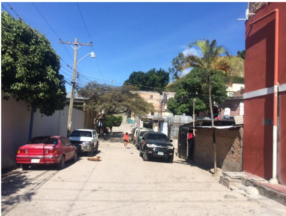
Inicio de calle a pavimentar tramo 2
