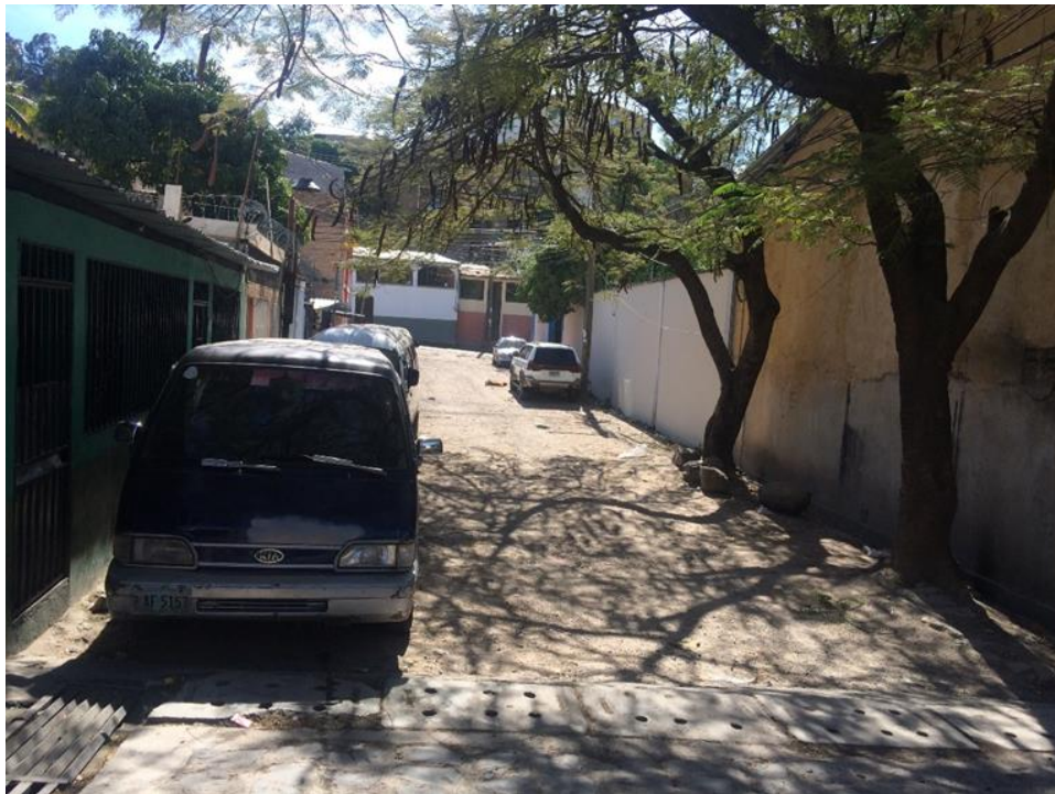
Vista de calle a pavimentar con concreto
