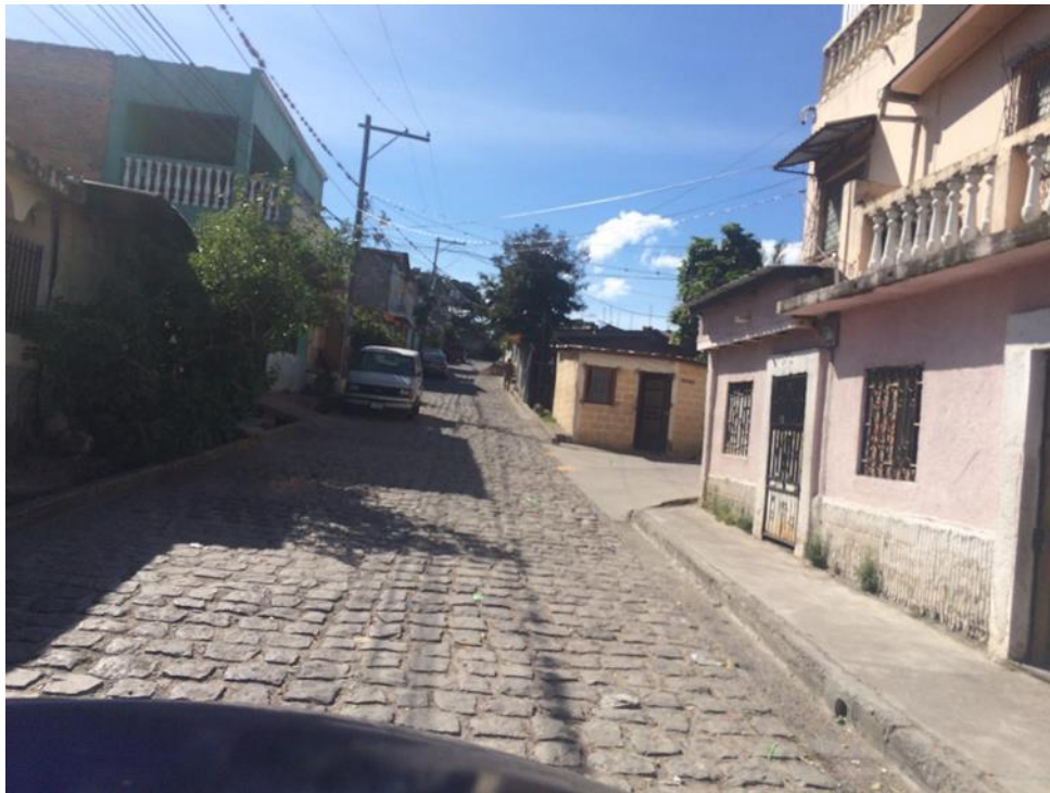
Inicio de calle a pavimentar tramo 4
