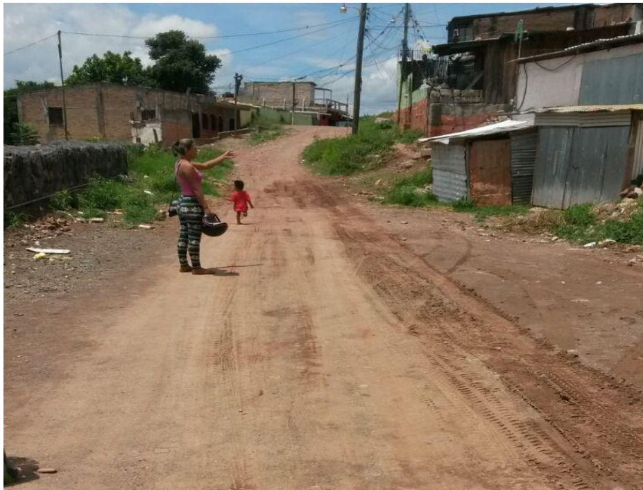
VISTA PANORAMICA DE LA CALLE
