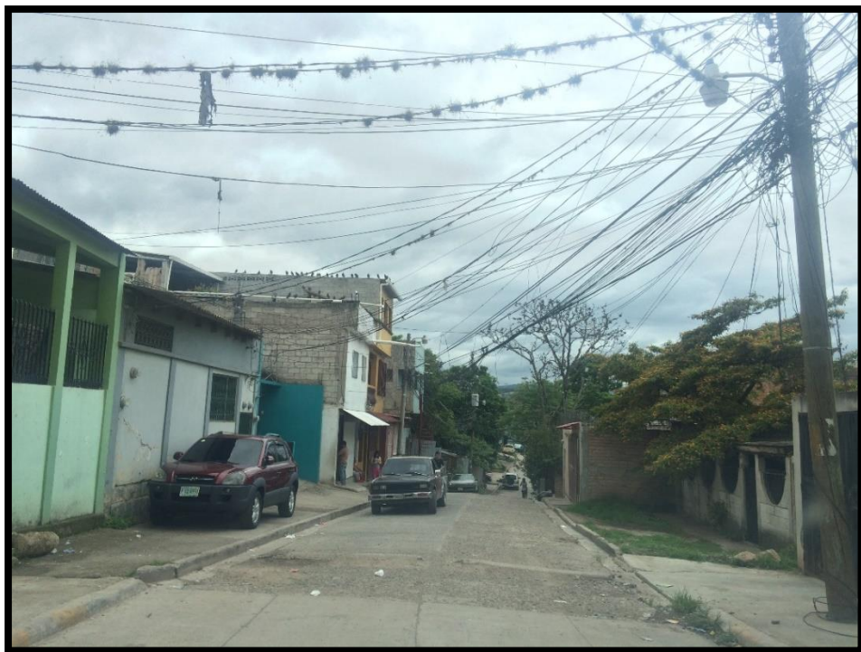
Foto No. 4: Final de tramo "B" a pavimentar
