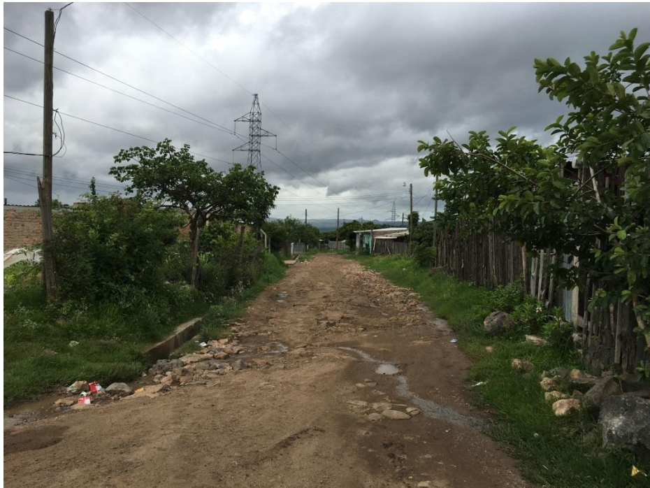
VISTA PANORAMICA DE TRAMO A REPARAR
