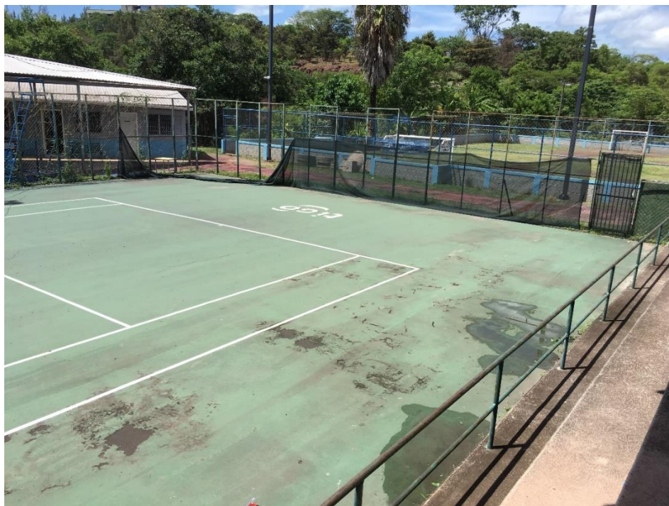
VISTA DE ESTADO ACTUAL DE CANCHA #1
