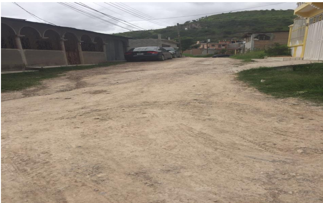
TRAMO A PAVIMENTAR
