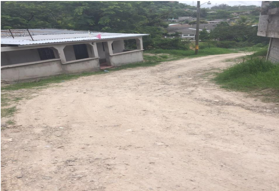
TRAMO A INSTALAR TUBERIA DE AGUAS NEGRAS Y PAVIMENTO
