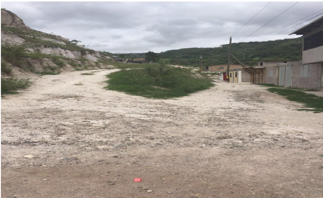
FINAL DE BALASTADO
