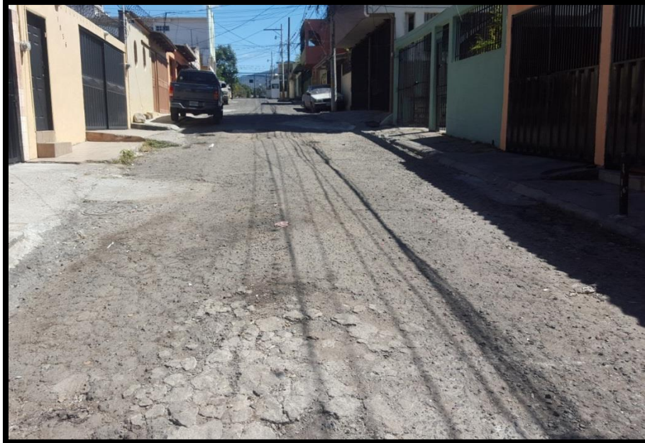
VISTA DEL INICIO DEL TRAMO A REHABILITAR
