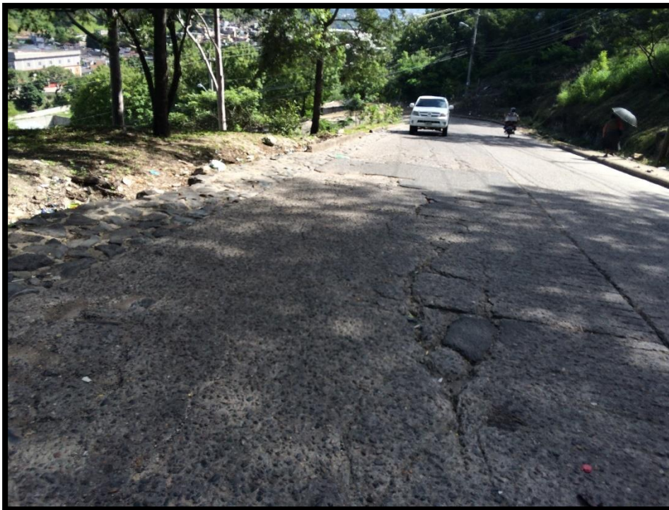
Foto No. 2: Ubicación del muro de contención
