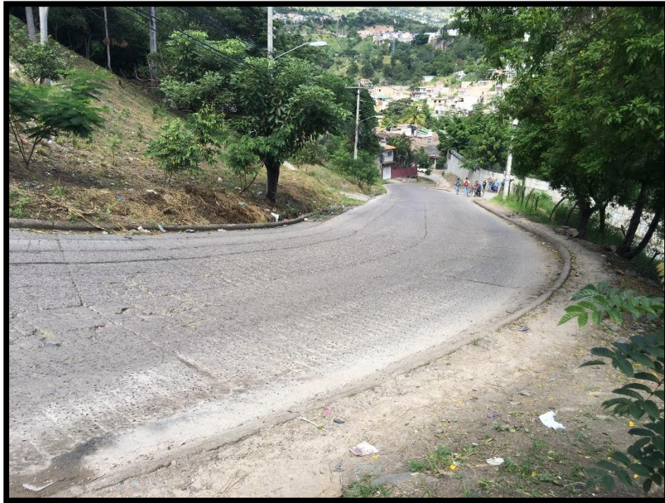
Foto No. 1: Inicio de calle
