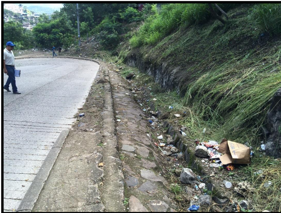
Foto No. 3: Vista de donde se ampliara la calzada
