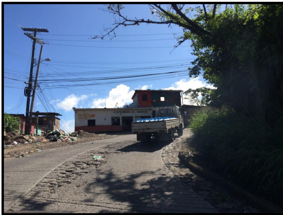
Foto No. 4: Final de calle a pavimentar
