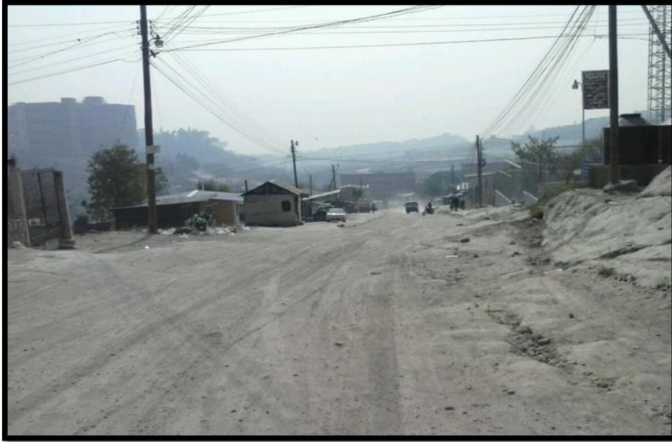
VISTA DEL INICIO DEL TRAMO A PAVIMENTAR
