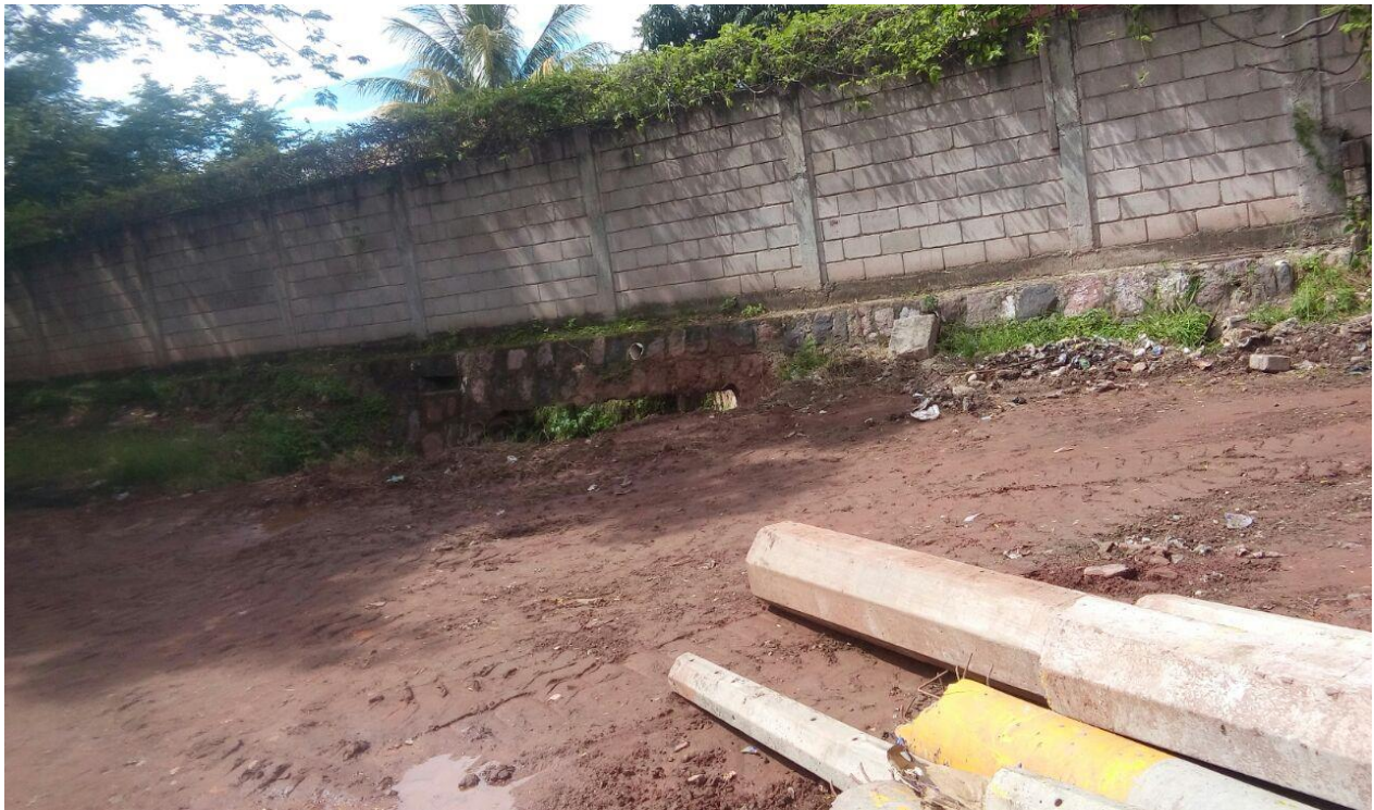
PANORAMA DONDE SE CONSTRUIRA EL MURO
