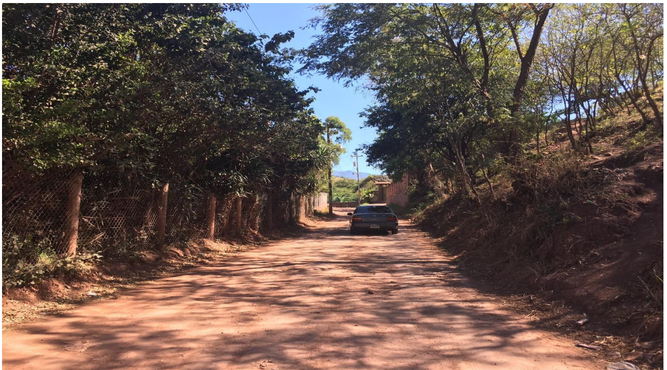
PANORAMA DE CALLE A REPARAR
