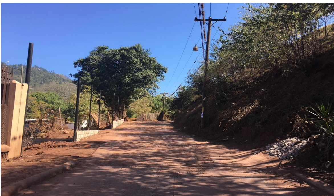
FINAL DE CALLE DONDE SE CONSTRUIRAN LAS HUELLAS
