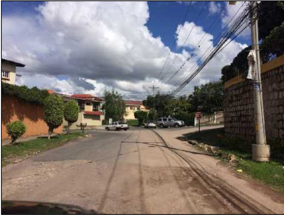
Foto 1. Inicio de calle a pavimentar
