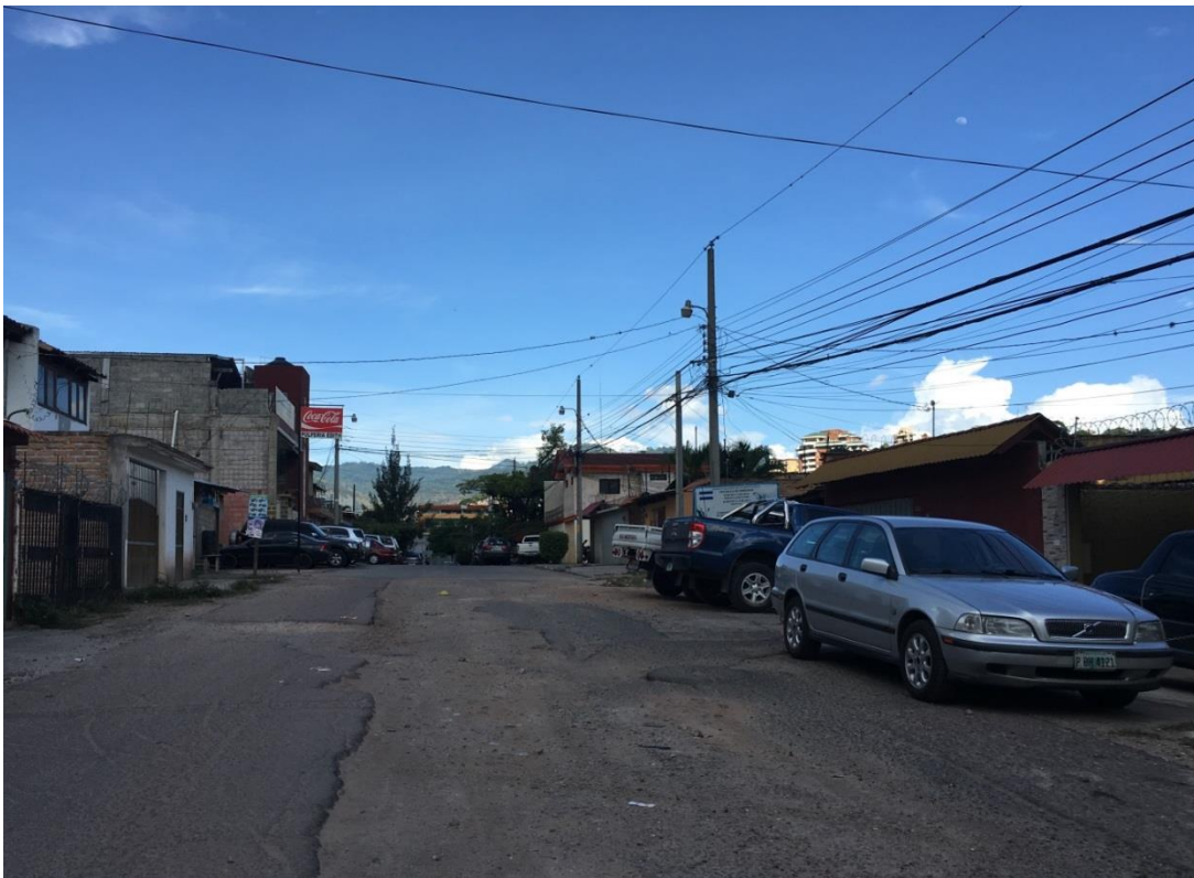
Calle a pavimentar con concreto hidráulico, tramo C
