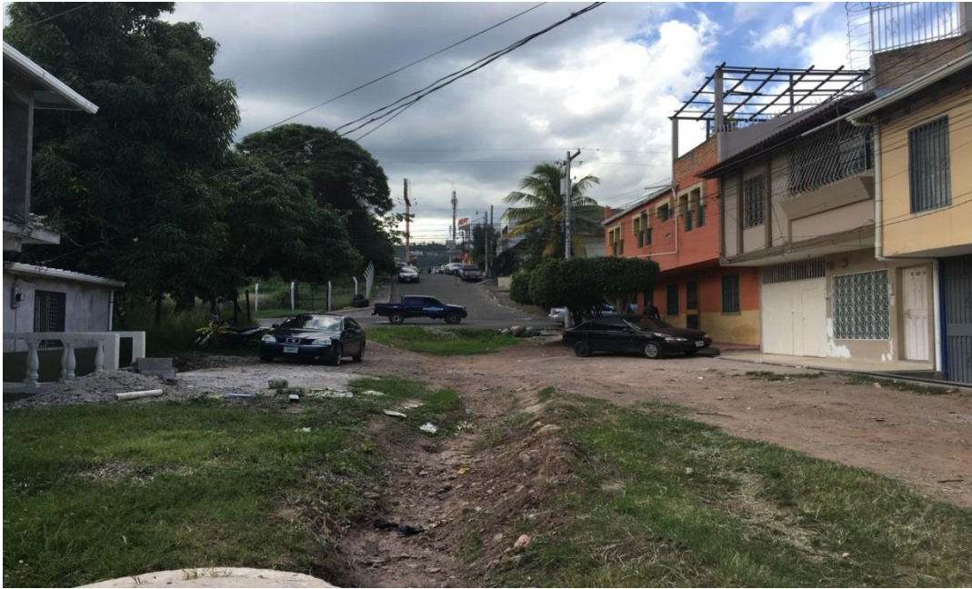
Panorama de calle a pavimentar con concreto hidráulico, tramo B
