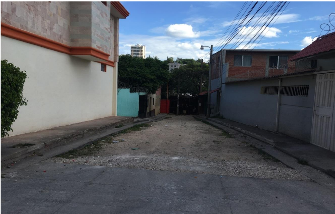
Calle a pavimentar con concreto hidráulico, tramo D
