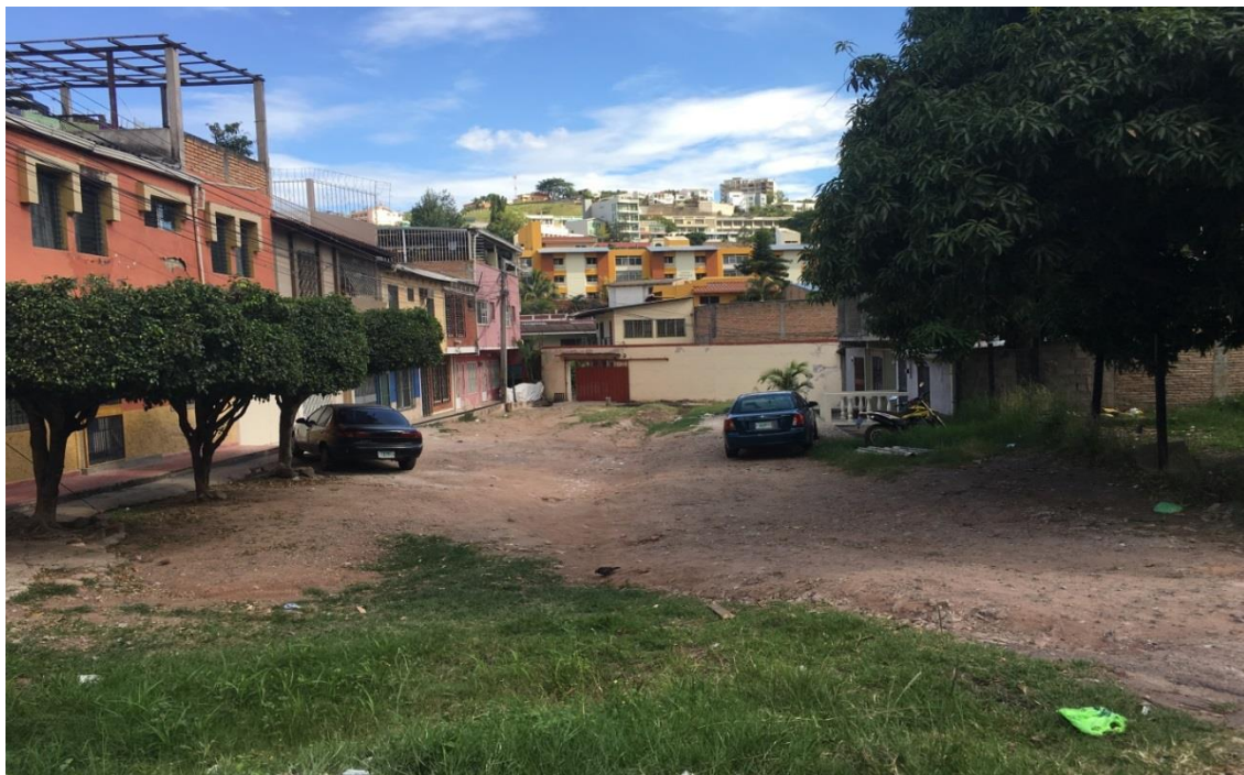
Calle a pavimentar con concreto hidráulico, tramo B
