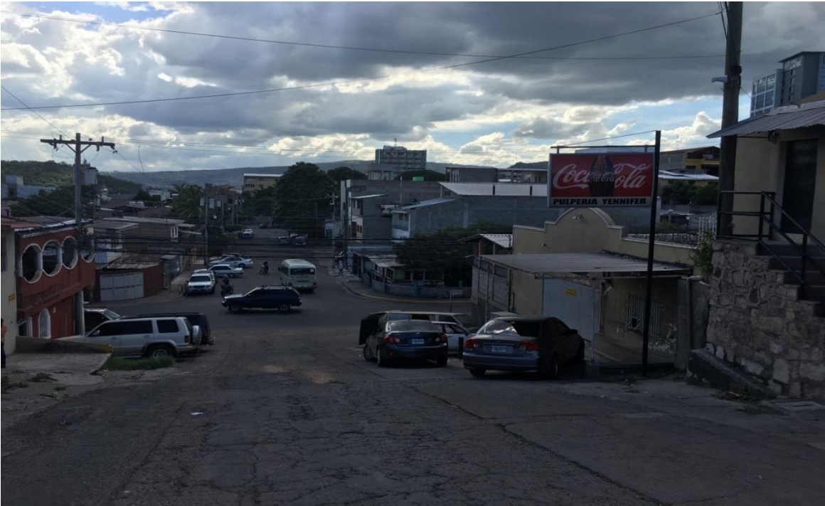
Panorama de calle a pavimentar con concreto hidráulico, tramo C
