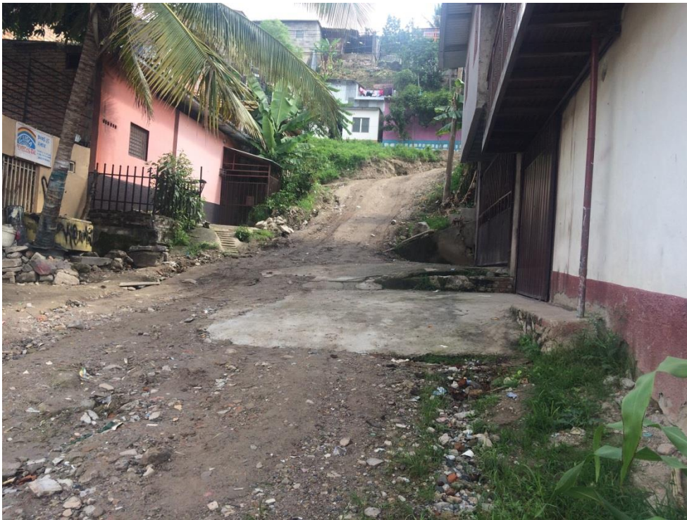
FOTO #3 CONDICIONES ACTUALES DE LA CALLE A PAVIMENTAR
