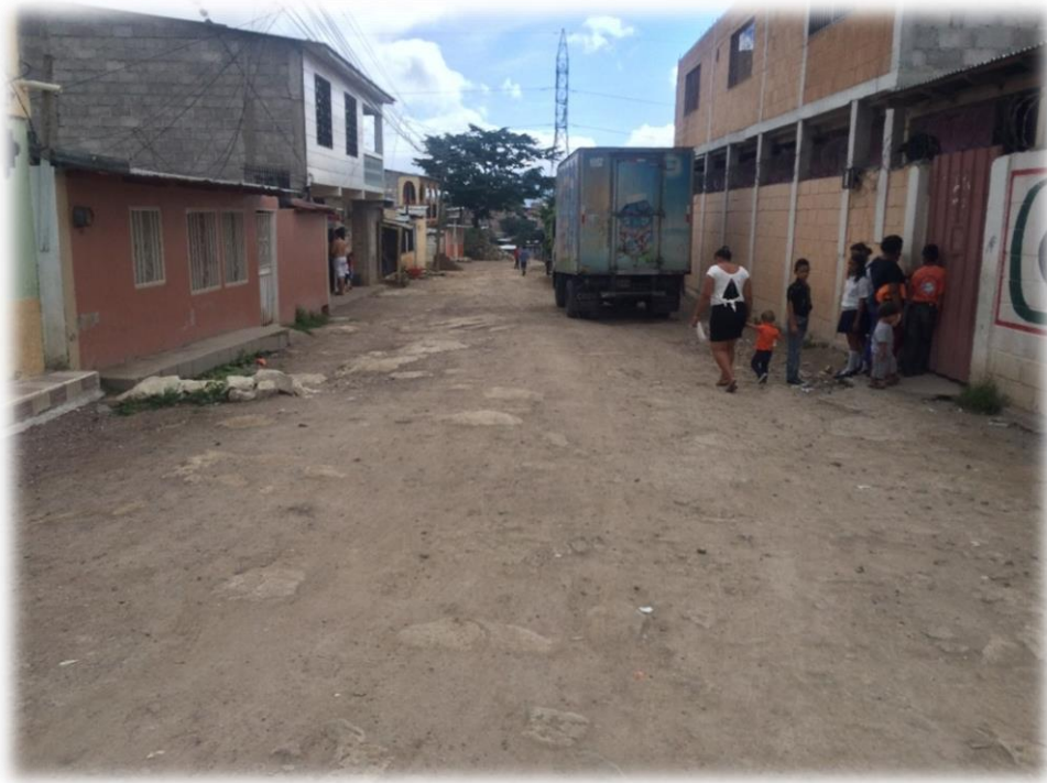
VISTA DEL ESTADO DE LA CALLE A PAVIMENTAR
