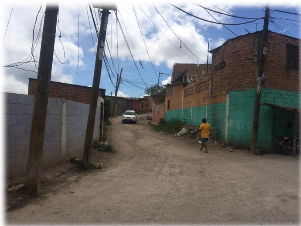
FINAL DE PAVIMENTO CON CONCRETO HIDRÁULICO
