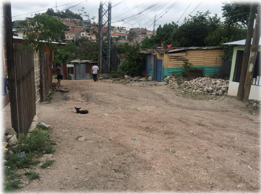
INICIO DE PAVIMENTACIÓN CON CONCRETO HIDRÁULICO
