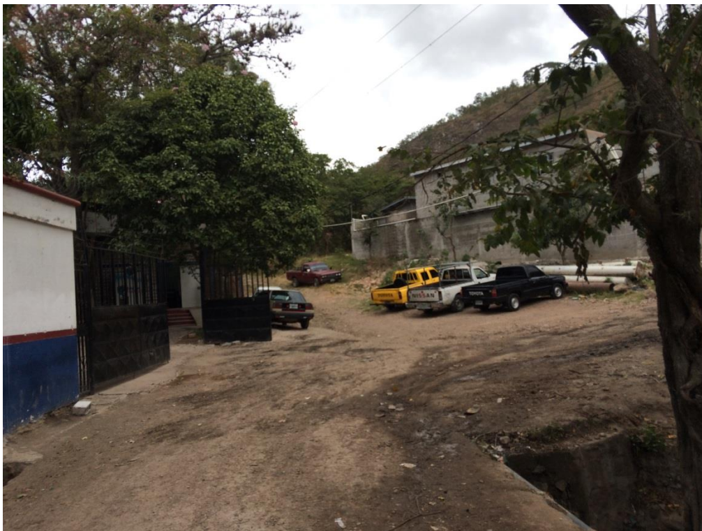
VISTA DE CALLE A PAVIMENTAR CON CONCRETO HIDRÁULICO
