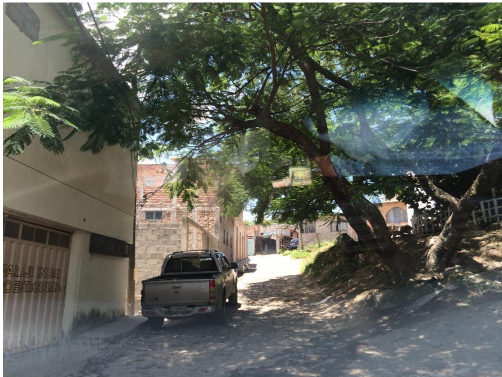
Panorama de calle que se pavimentará con White Topping
