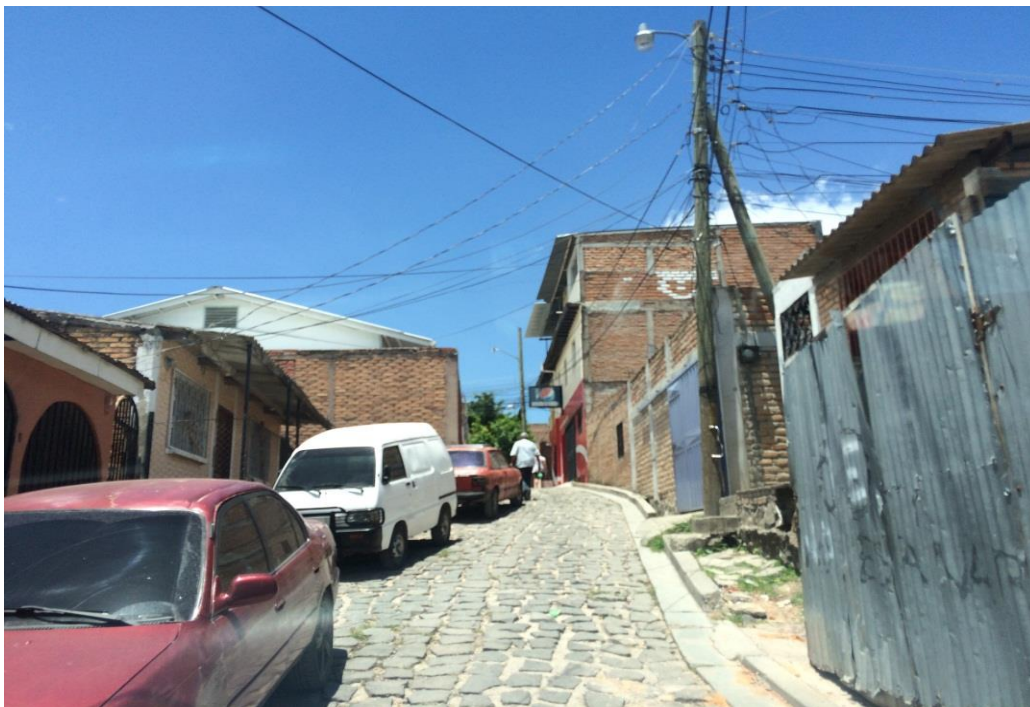
Panorama de calle a pavimentar con White Topping
