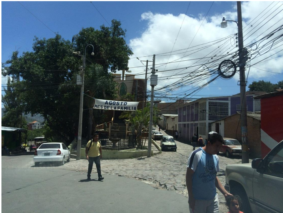
Inicio de calle que se pavimentará con White Topping
