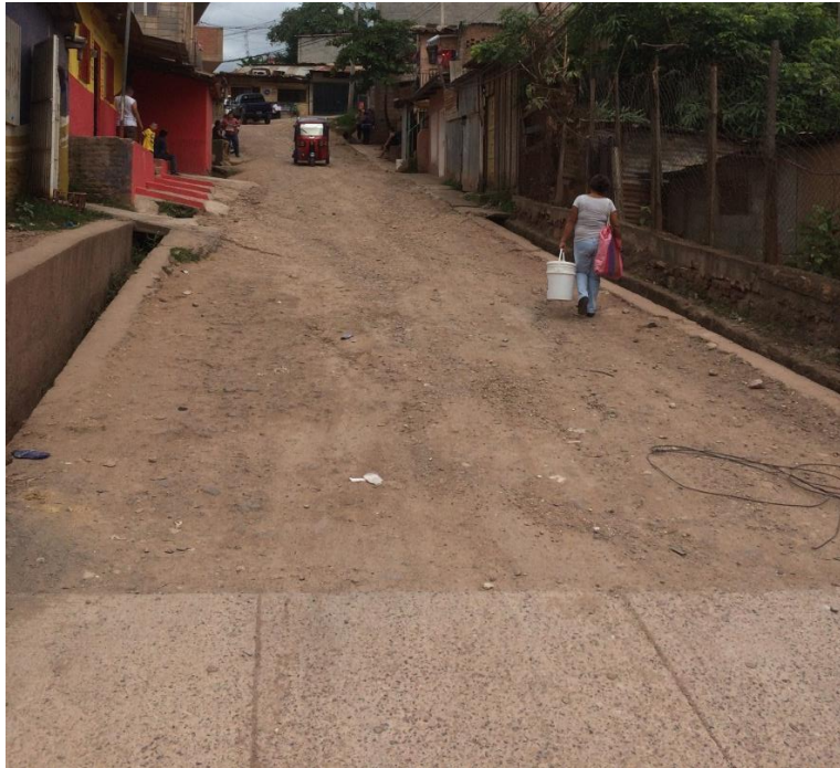
Inicio de calle a pavimentar con concreto hidráulico
