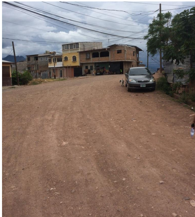
Panorama de calle a pavimentar con concreto hidráulico
