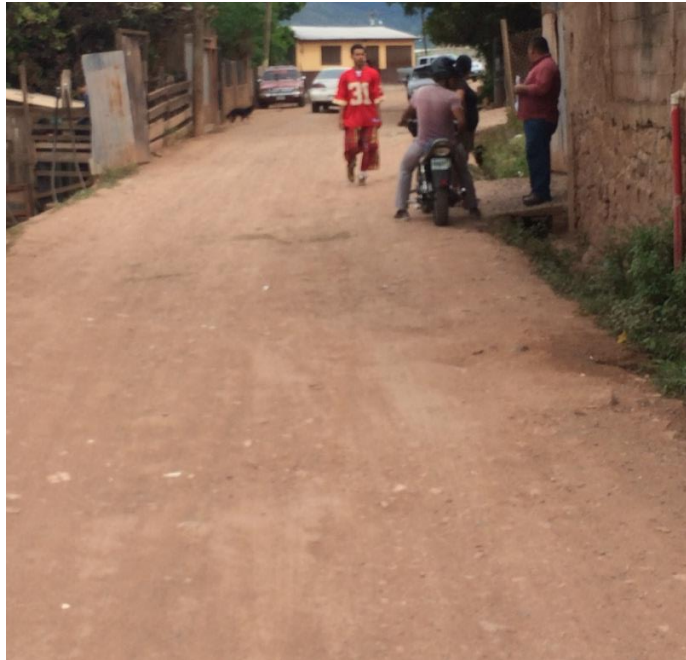
Panorama de calle a pavimentar con concreto hidráulico
