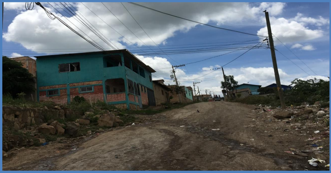
Vista de la calle principal donde se construirán cunetas
