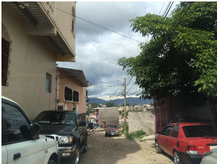
Panorama del tramo a pavimentar con concreto hidráulico
