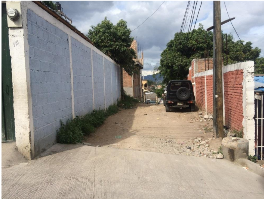
Inicio del segundo tramo a pavimentar con concreto hidráulico
