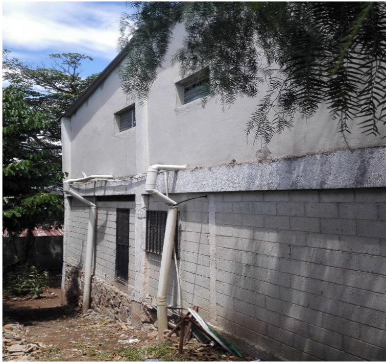
Foto No. 3: Vista donde se construirá los semilleros
