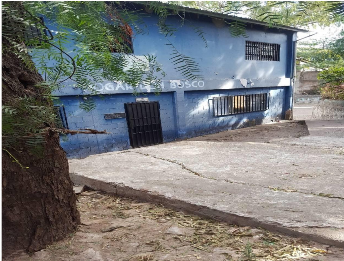
Foto No. 2: Estado actual de la entrada principal
