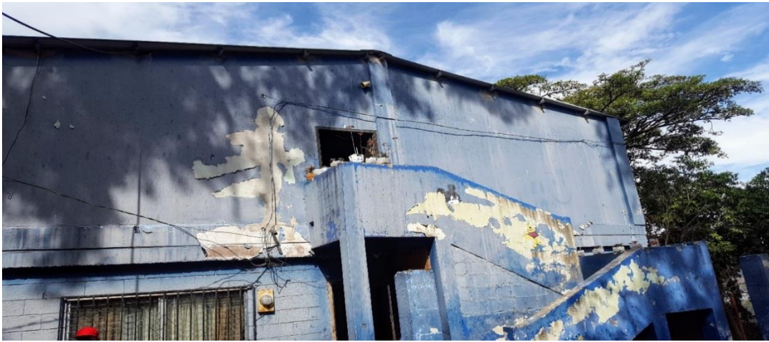
Foto N° 1 Estado actual del exterior del edificio existente
