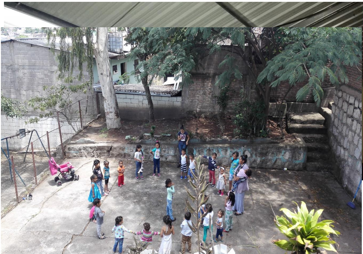
Foto No. 4: Estado segundo nivel del edificio
