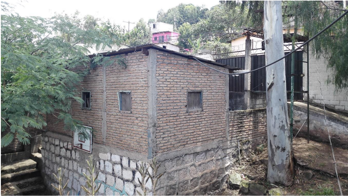
Foto No. 6: Edificación que se acondicionará la Clínica Dental
