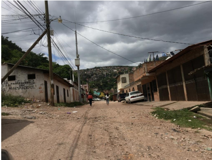
Panorama del tramo a pavimentar con concreto hidráulico y sección en donde se construirán las cunetas
