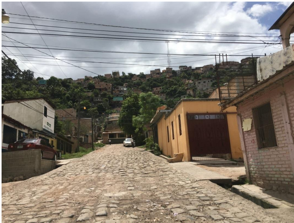
Panorama de tramo en el que se demolerá el empedrado
