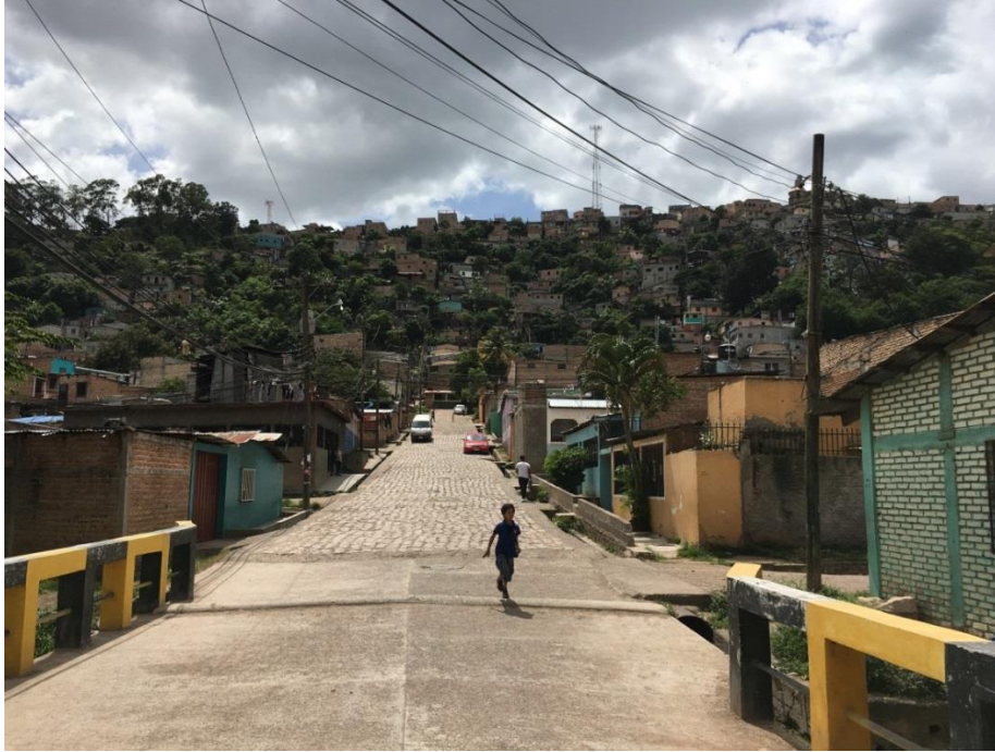
Inicio de tramo en el que se demolerá el empedrado
