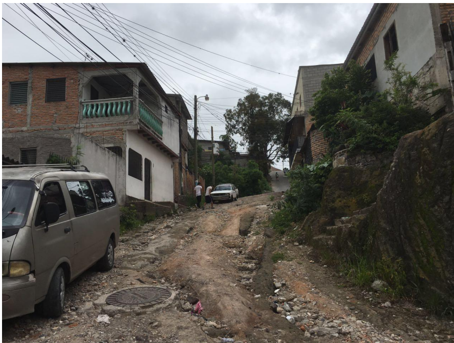
VISTA DE ESTADO ACTUAL DE CALLE A PAVIMENTAR
