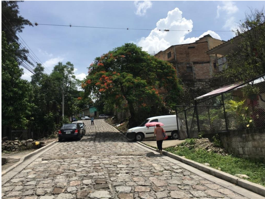
VISTA PANORAMICA DE CALLE A PAVIMENTAR (WHITE TOPPING)
