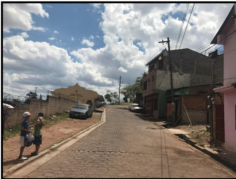
Foto No. 2: Estado actual de la calle
