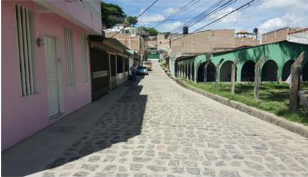
INICIO DE WHITE TOPPING TRAMO B
