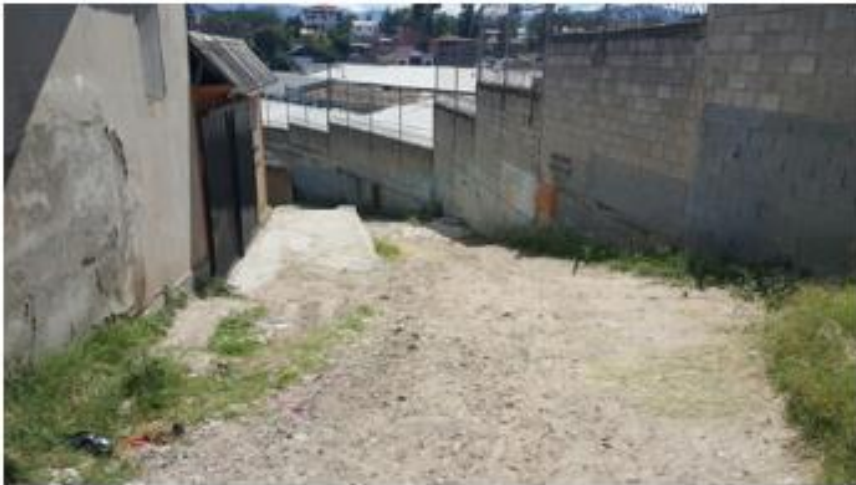
VISTA DEL TRAMO A PAVIMENTAR CON CONCRETO HIDRAULICO
