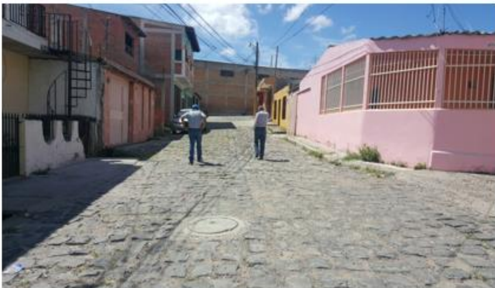
VISTA DE TRAMO A PAVIMENTAR CON WHITE TOPPING TRAMO B
