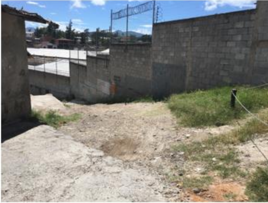
INICIO DE PAVIMENTACION CON CONCRETO HIDRAULICO, TRAMO A
