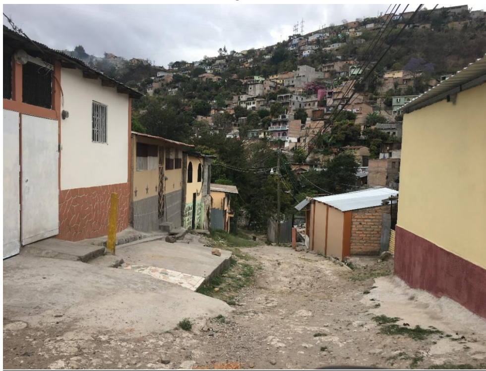
Foto No. 3: Foto tramo a pavimentar
