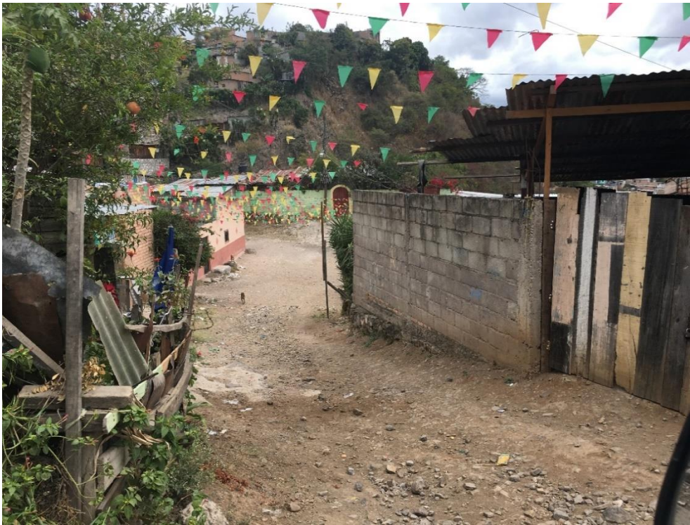
Foto No. 2: tramo a pavimentar
