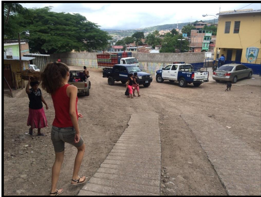
VISTA DEL TRAMO A PAVIMENTAR FRENTE A LA POSTA POLICIAL
