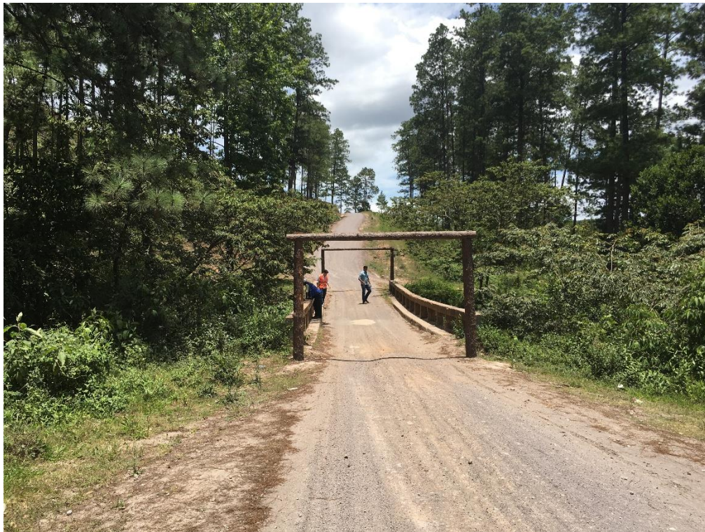
Vista del sitio donde se reconstruirá el puente
