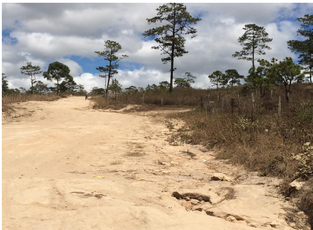
Vista de otro sitio de la calle donde se conformará y balastará
