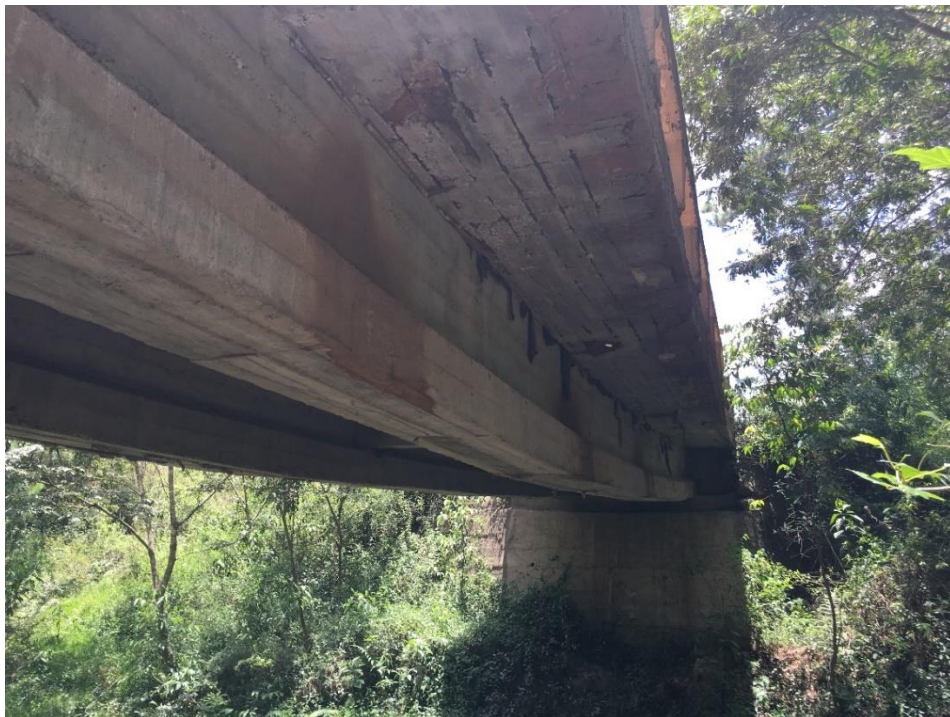
Vista de estructura parte inferior del puente, donde se observa el acero de refuerzo
