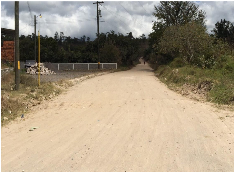
Vista del inicio de calle a conformar y balastar
