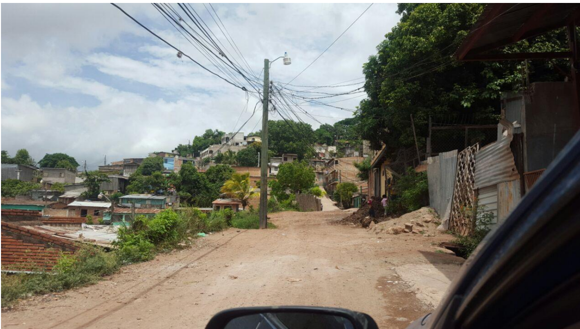
Panorama del tramo a pavimentar con concreto hidráulico
