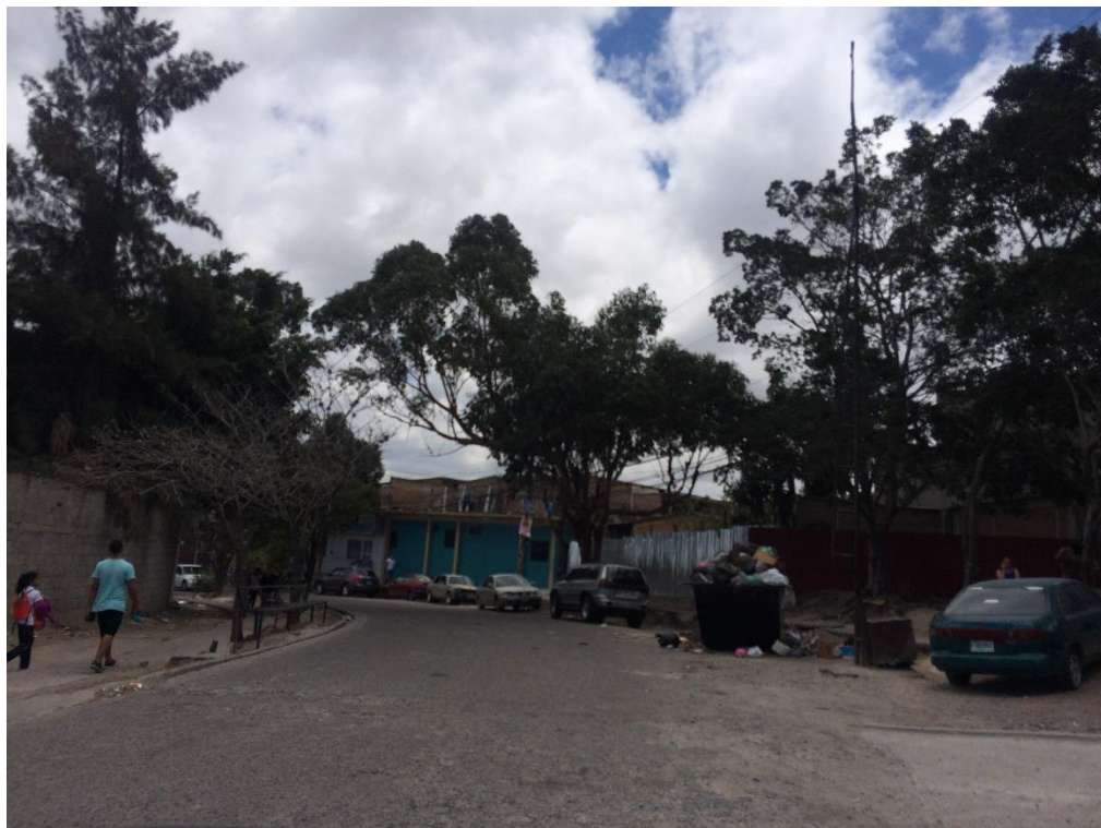
Foto No. 2: Vista donde se desmontará el adoquín"
