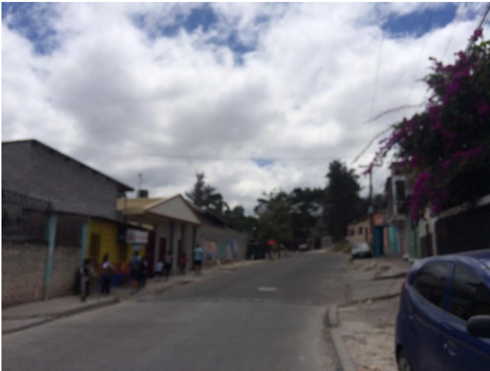
Foto No. 1: Inicio de calle a pavimentar
