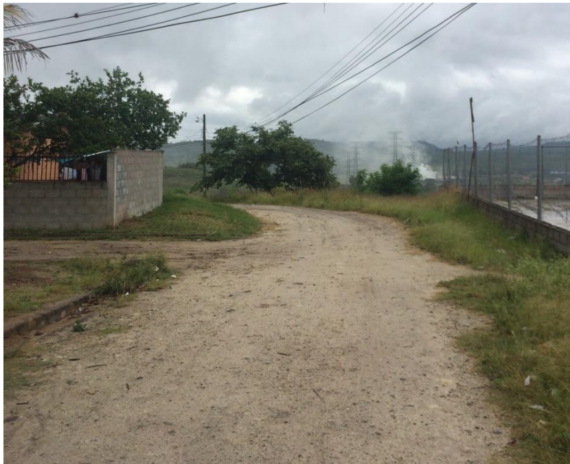
Panorama del tramo en el que se hará el balastado
