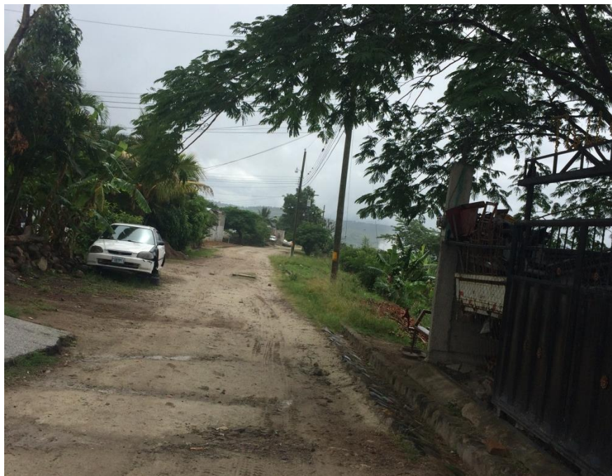
Panorama del tramo en el que se hará el balastado
