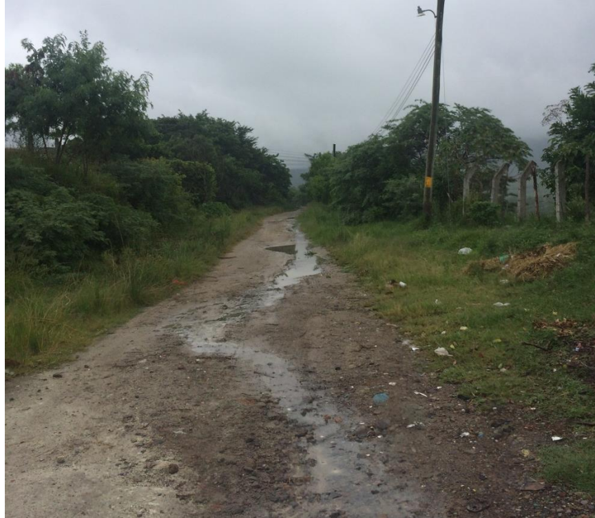
Inicio del tramo #2 en el que se hará el balastado
