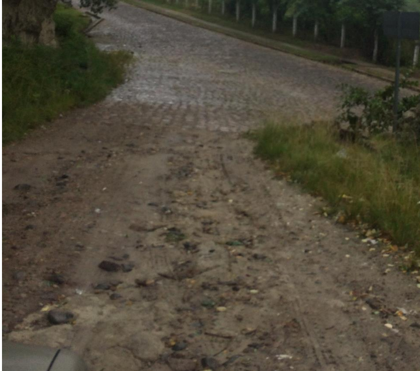
Inicio del tramo #1 en el que se hará el balastado
