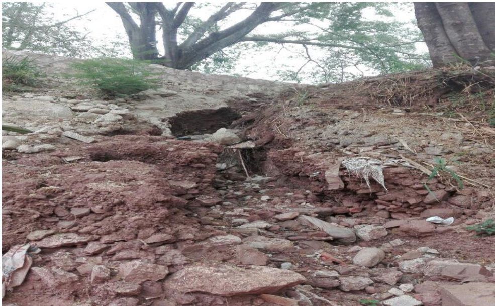
Vista donde se construirá la cuneta en la cancha no. 1
