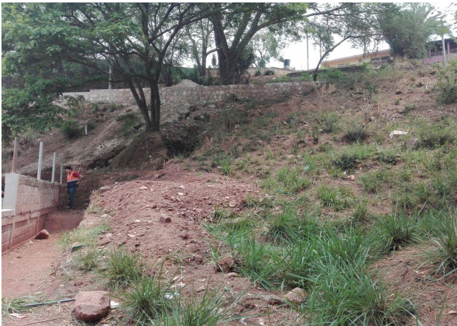
Área donde se construirá la gradería
