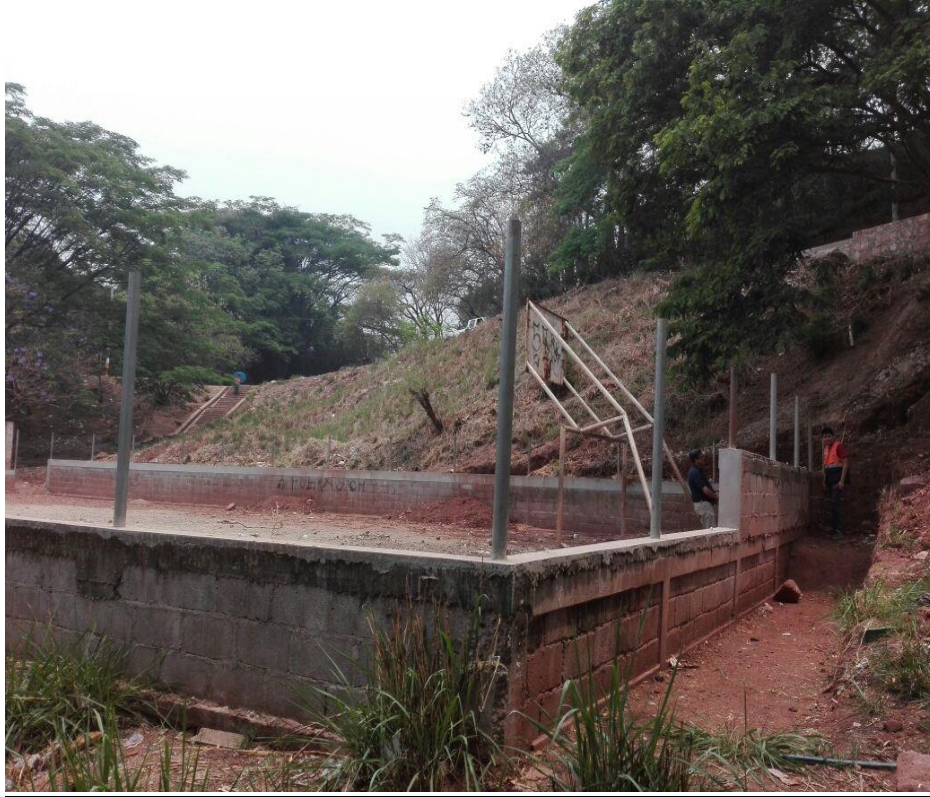
Estado actual de la cancha no. 1
