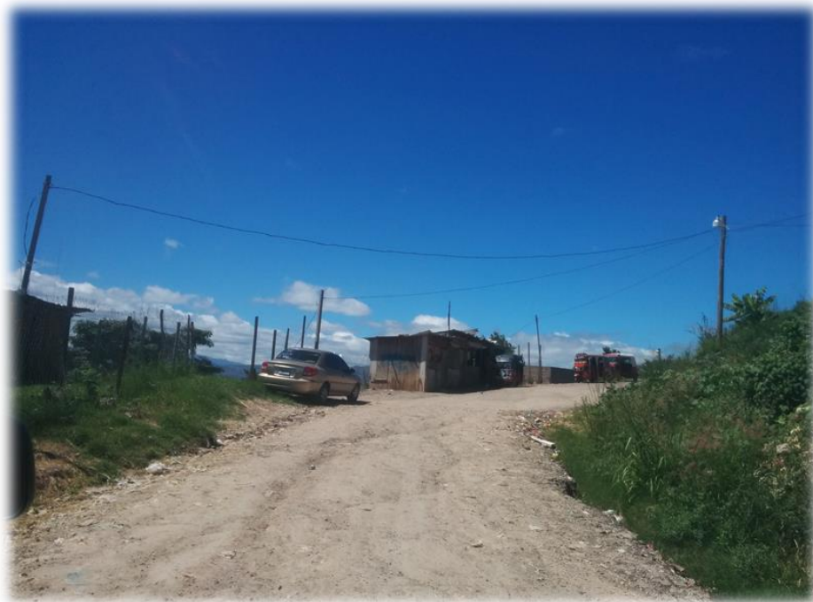
ESTADO DEL LUGAR DONDE SE CONSTRUIRAN LAS CUNETAS
