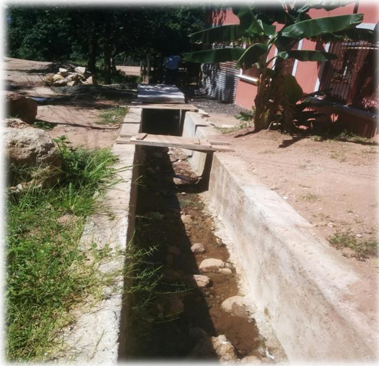
TRAMO DE CUNETAS EXISTENTE
