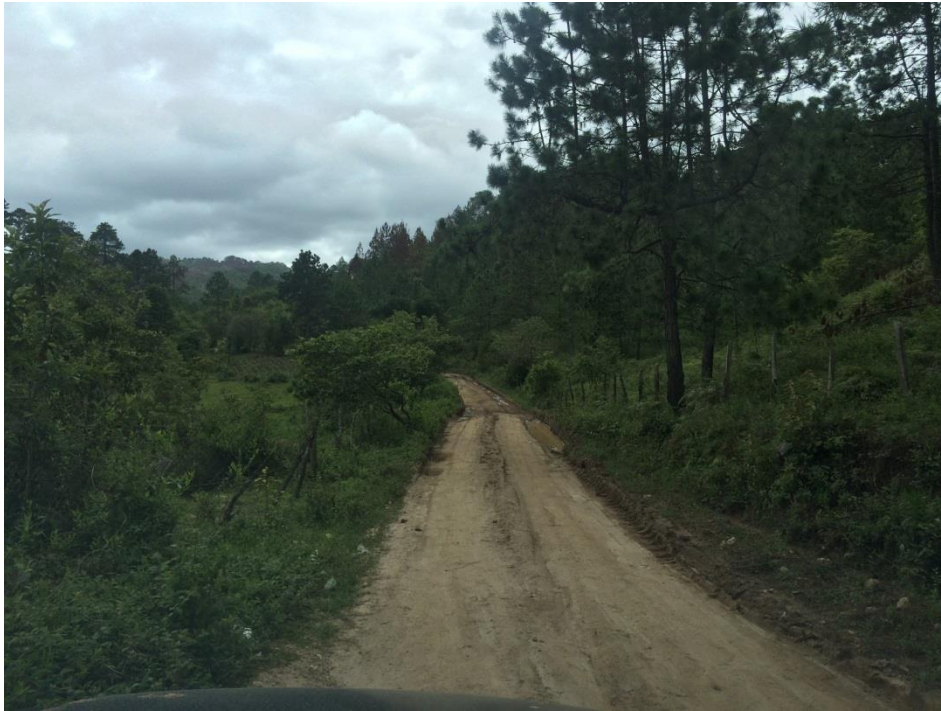
VISTA ACTUAL DE TRAMO A REPARAR
