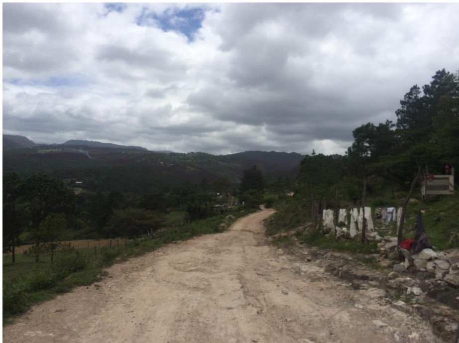
VISTA PANORAMICA DE TRAMO A REPARAR
