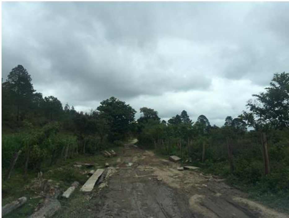
VISTA ACTUAL DEL MAL ESTADO DEL CAMINO
