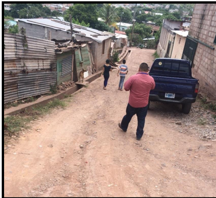
PANORAMICA DEL TRAMO A PAVIMENTAR
