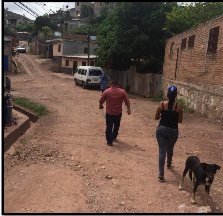
PANORAMICA DEL TRAMO A PAVIMENTAR
