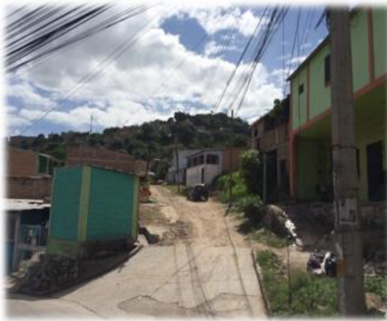
INICIO DE PAVIMENTACION CON CONCRETO HIDRAULICO. TRAMO A
