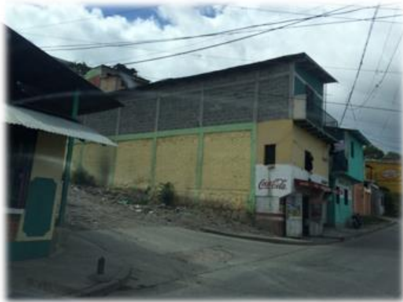
INICIO DE WHITE TOPPING TRAMO B
