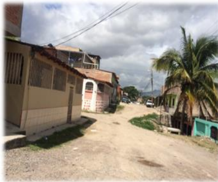
VISTA DEL ESTADO DE LA CALLE A PAVIMENTAR
