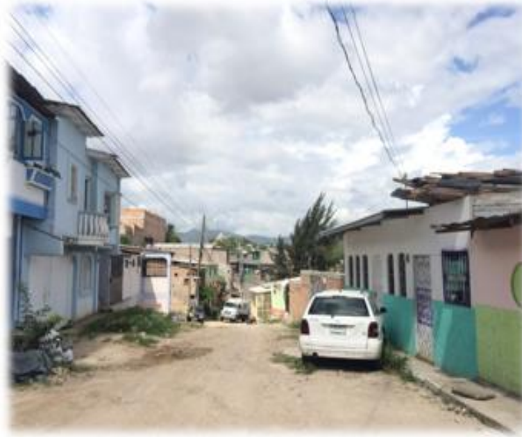
VISTA DEL TRAMO A PAVIMENTAR CON CONCRETO HIDRAULICO
