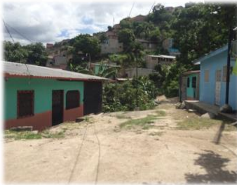
FINAL DE PAVIMENTACIÓN CON CONCRETO HIDRAULICO. TRAMO A
