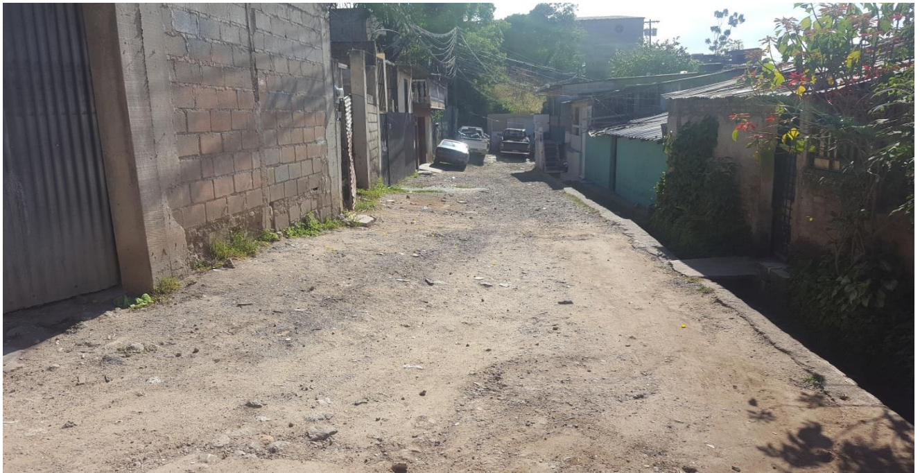
PANORAMA DE CALLE A PAVIMENTAR CON CONCRETO HIDRAULICO
