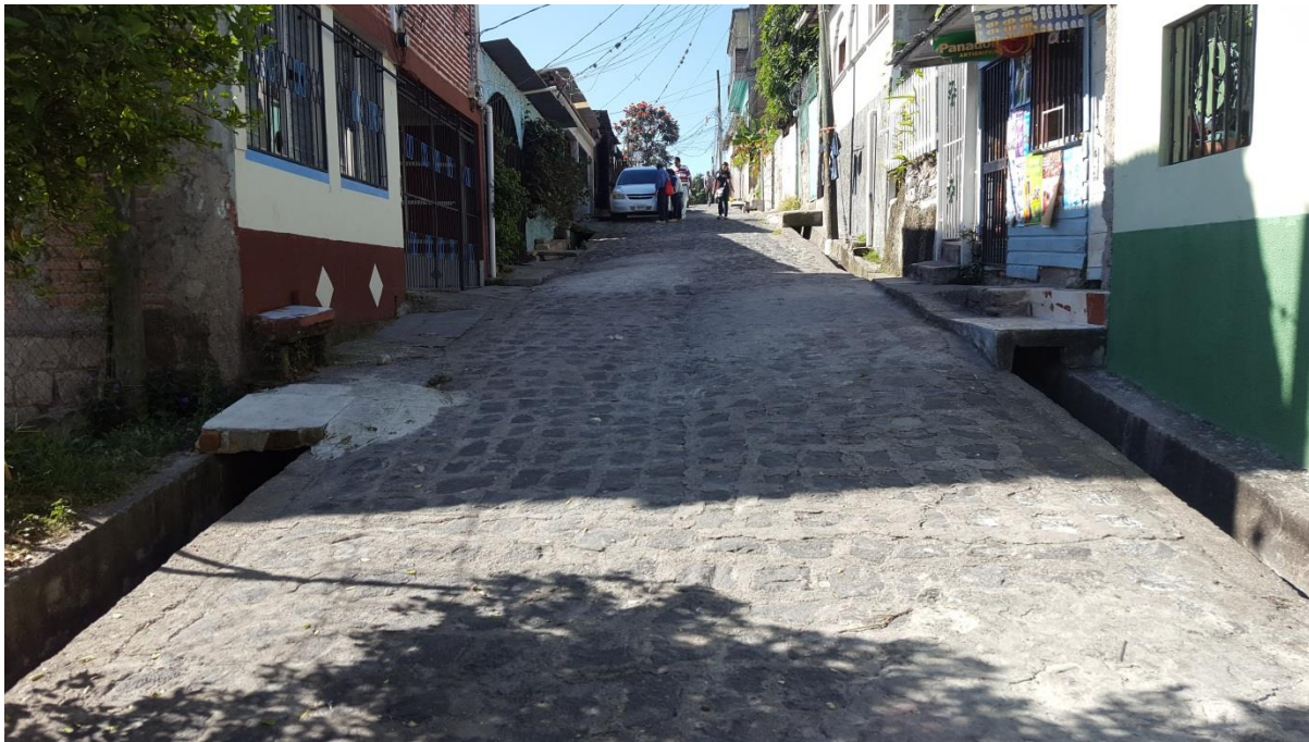
VISTA DE CALLE A PAVIMENTAR
