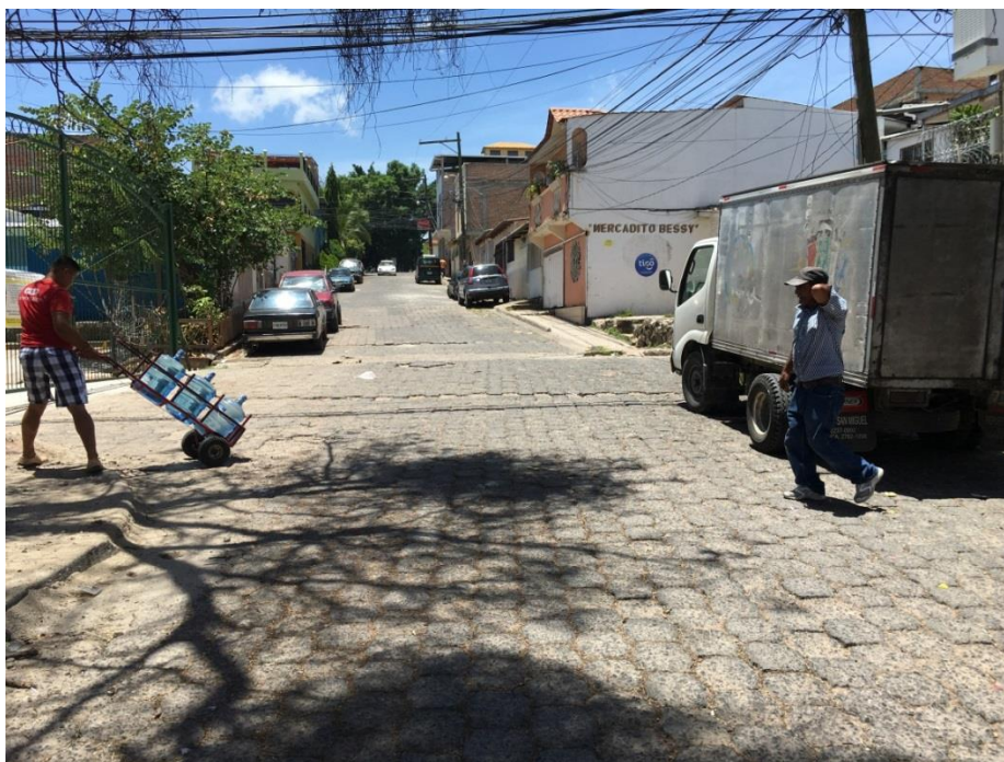
Panorama de tramo a pavimentar con concreto hidráulico
