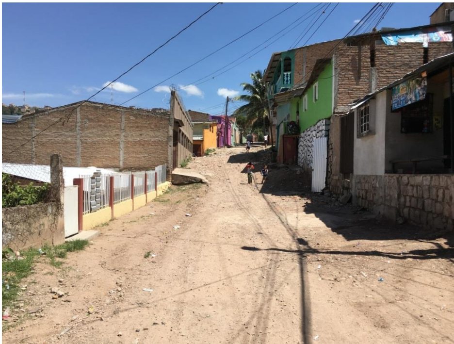
VISTA PANORAMICA DE CALLE A PAVIMENTAR
