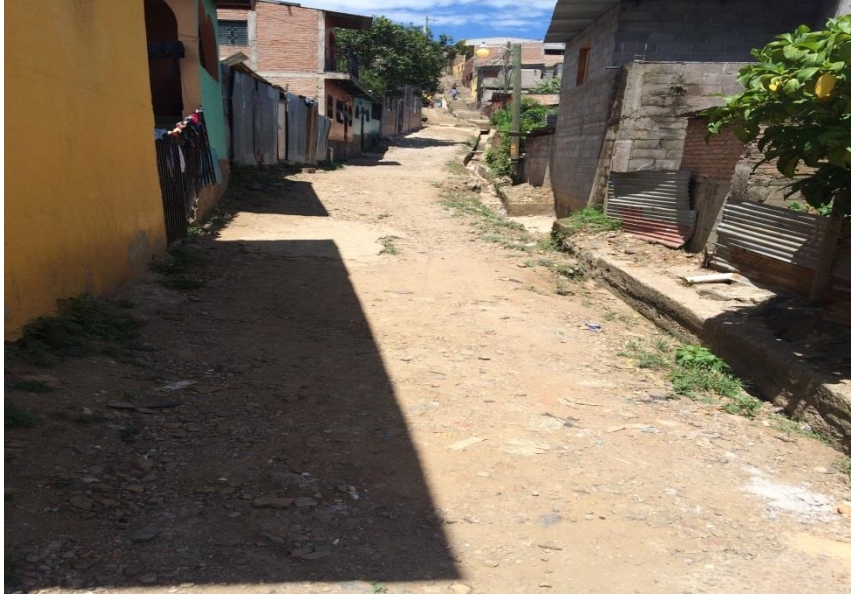
Calle a pavimentar
