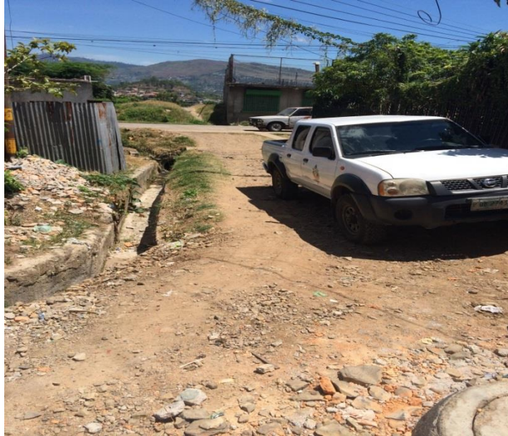
Inicio de calle a pavimentar
