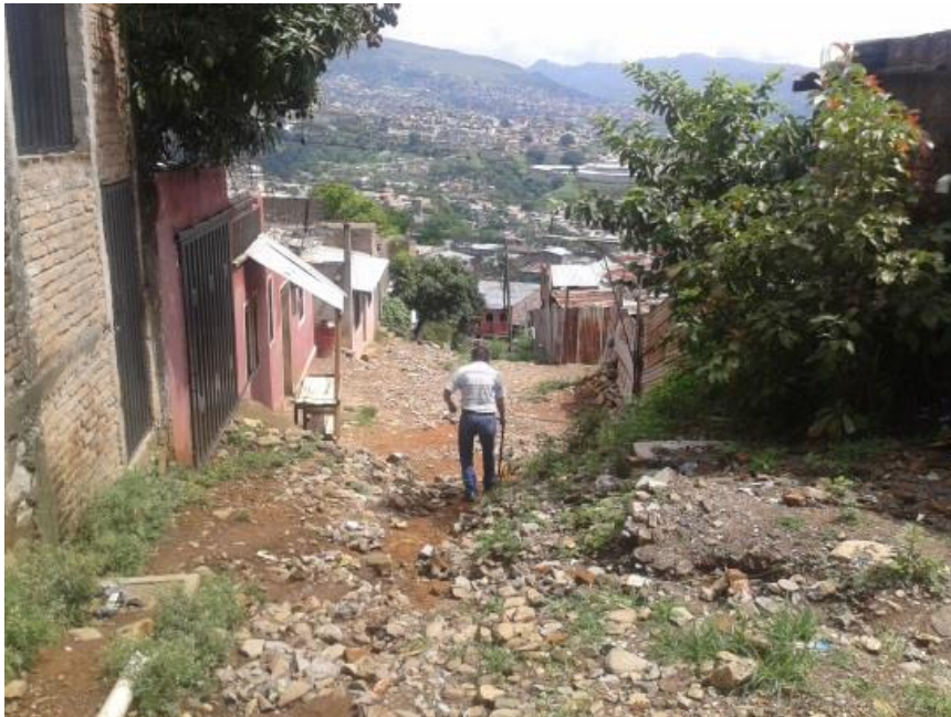
Calle a pavimentar
