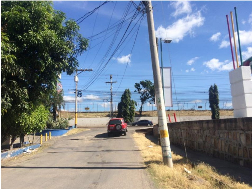
Inicio de calle "A"
