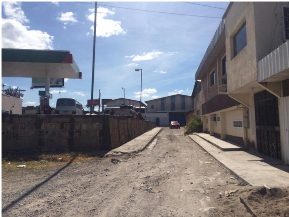
Panorama de calle a pavimentar
