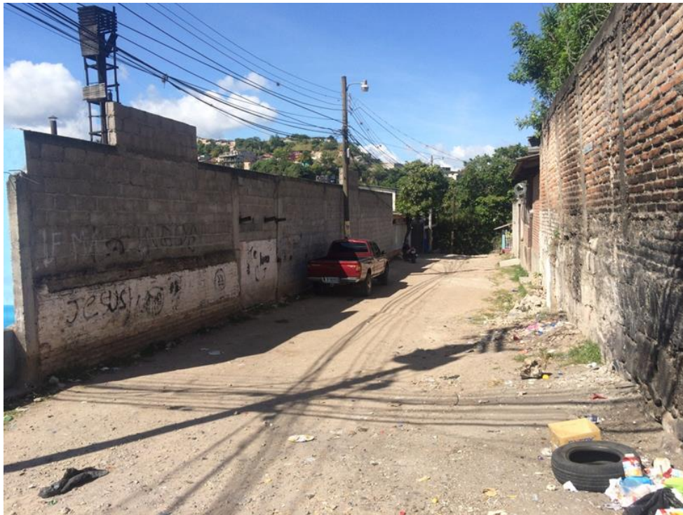
Vista panorámica de calle "B"
