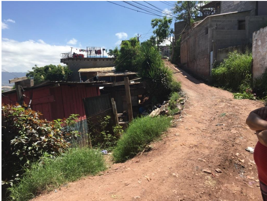
Ubicación en donde se construirá el muro de contención
