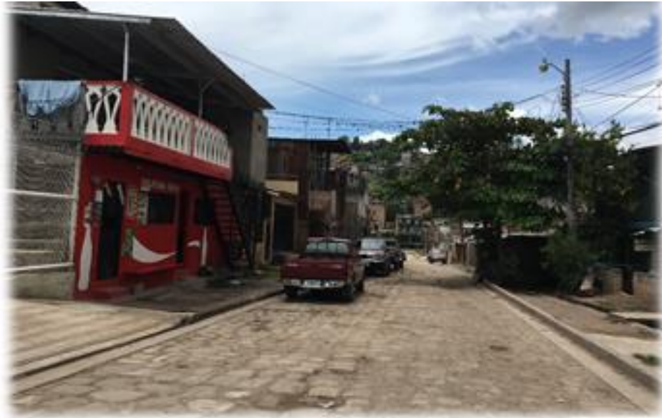
VISTA DEL ESTADO DE LA CALLE A PAVIMENTAR. TRAMO C.
