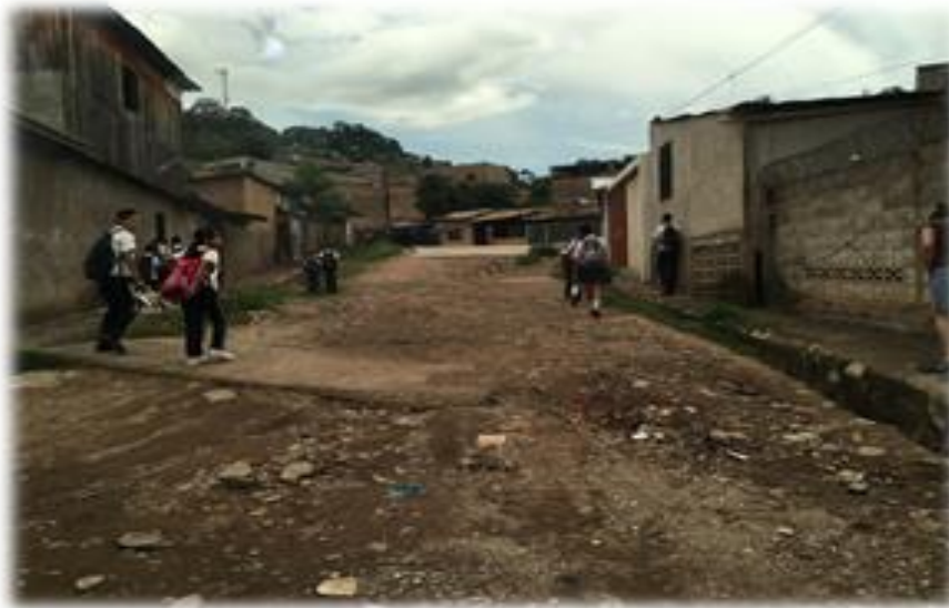
VISTA DE CALLE A PAVIMENTAR. TRAMO B.
