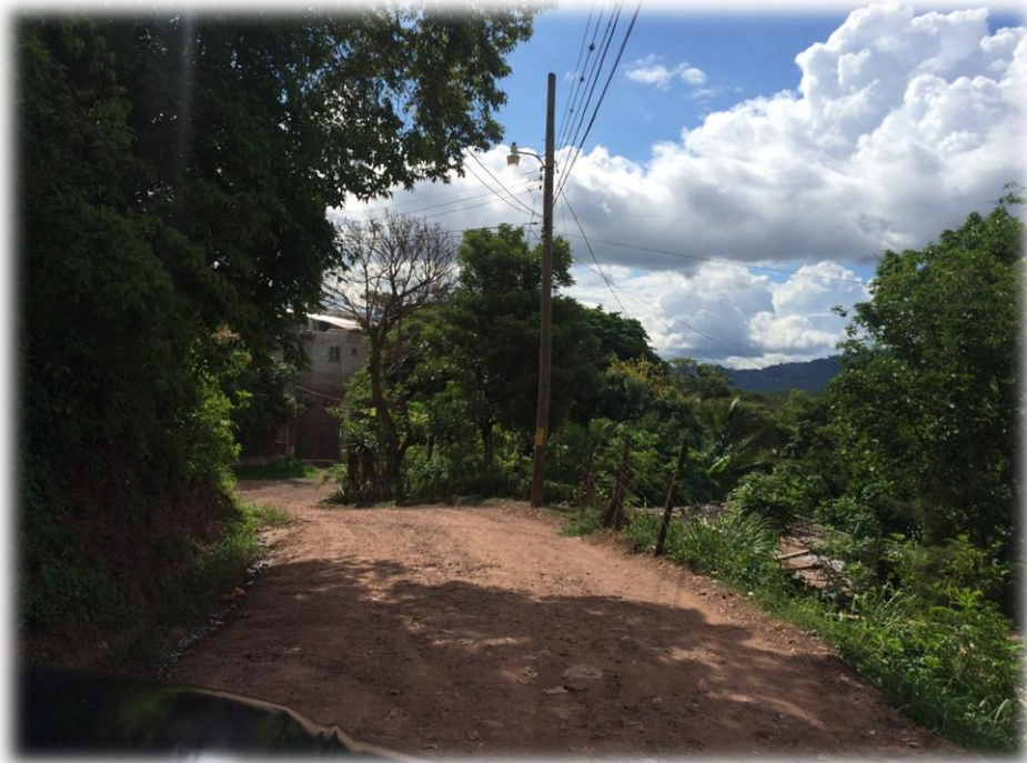
FINAL DE CALLE A PAVIMENTAR
