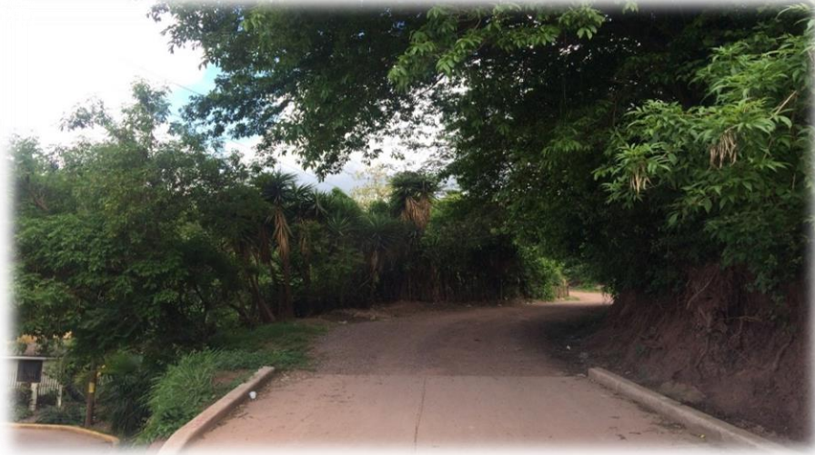
INICIO DE CALLE A PAVIMENTAR
