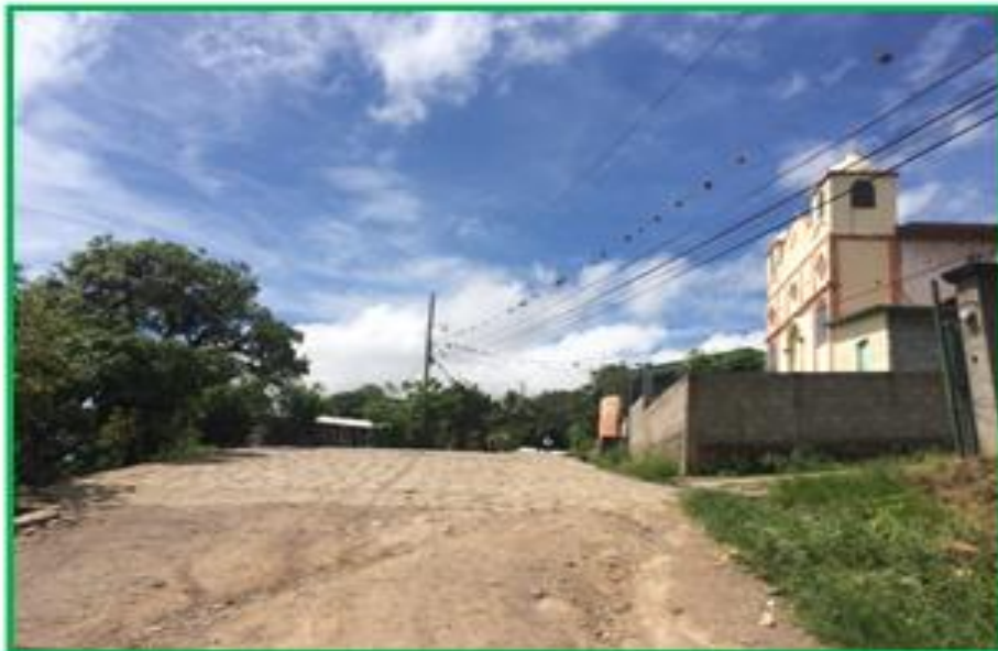
Final de calle en la que se hará el balastado
