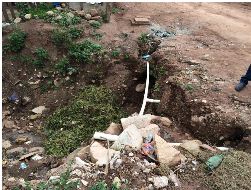
VISTA SITIO DONDE SE CONSTRUIRA MURO DE MAMPOSTERIA
