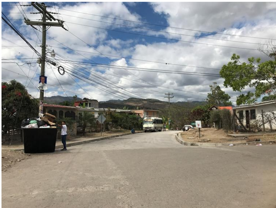
FINAL DE CALLE A PAVIMENTAR CON CONCRETO HIDRÁULICO
