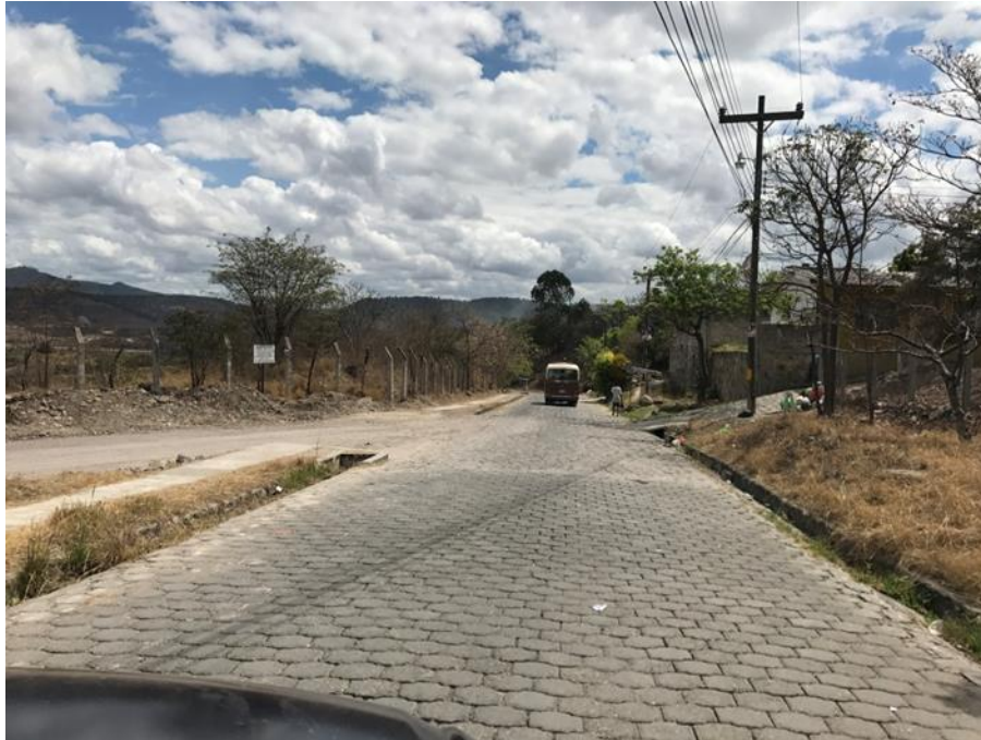
INICIO DE CALLE EN QUE SE DESMONTARÁ ADOQUÍN Y SE PAVIMENTARÁ CON CONCRETO HIDRÁULICO
