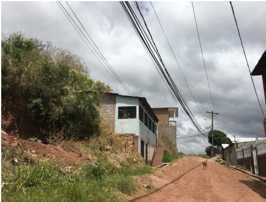
Foto No. 1: Inicio de calle "A"
