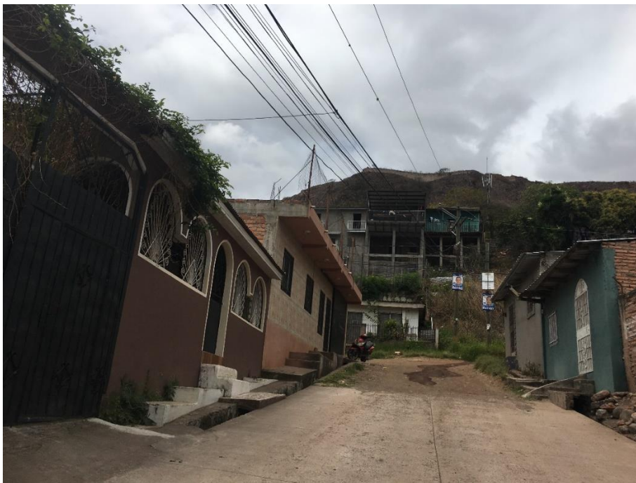
Foto No. 2: Estado actual de la calle
