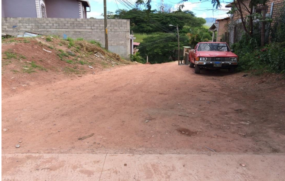
INICIO DE PAVIMENTACION DE CALLE
