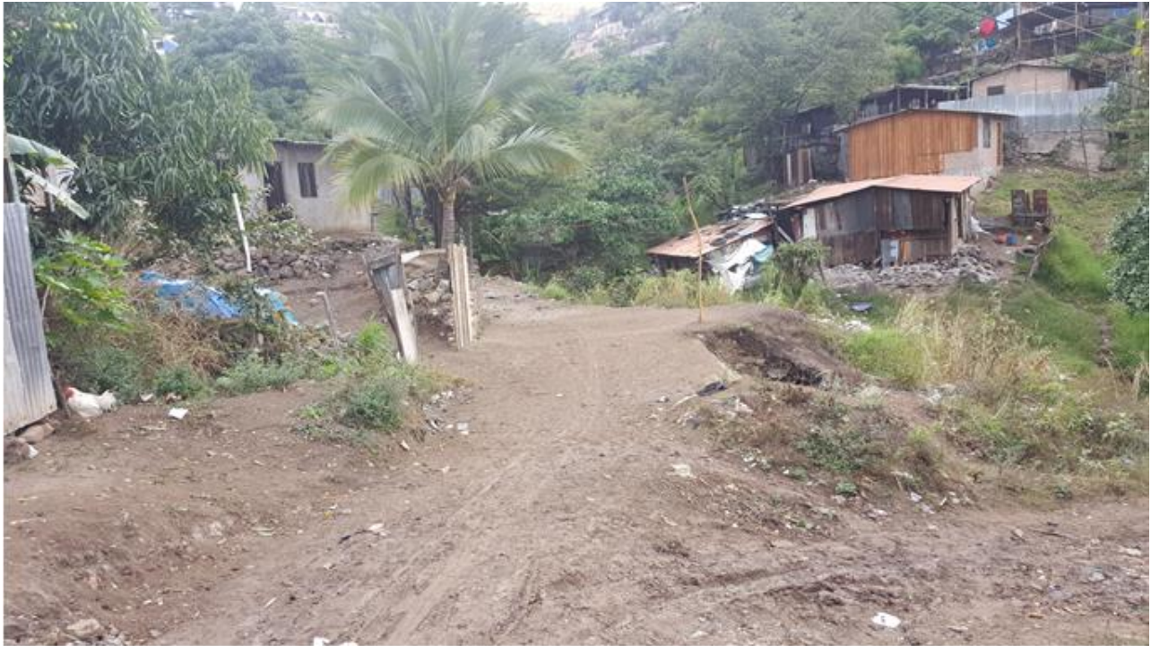
Vista del mal estado de la calle
