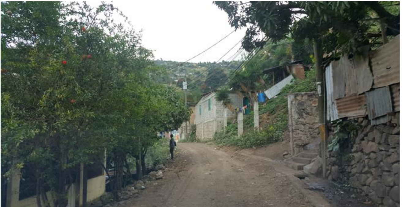
Vista panorámica de la calle a reparar
